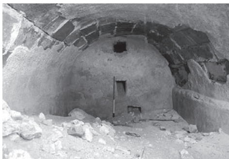
Fig. 6. Citerne à voûte avec l'intrados recouvert de tuiles (Site 45).
