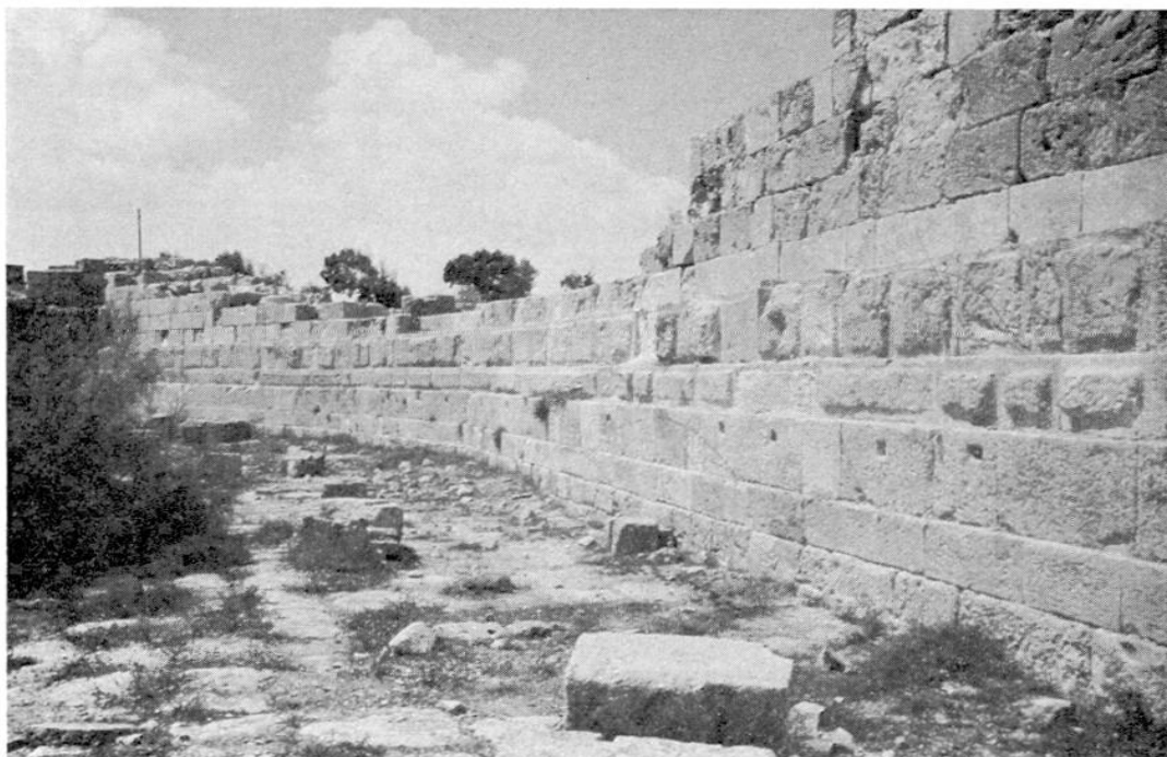
FIG. 9. — Face orientale du môle oriental avec, au premier plan l'aire dallée et, creusés dans la paroi arrière du portique, les points d'amarrage (photo A. Laronde).
