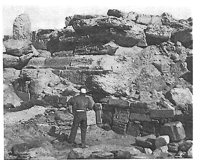
1-2. Parte di un architrave riutilizzato in un muro tardo e particolare dello stesso.
