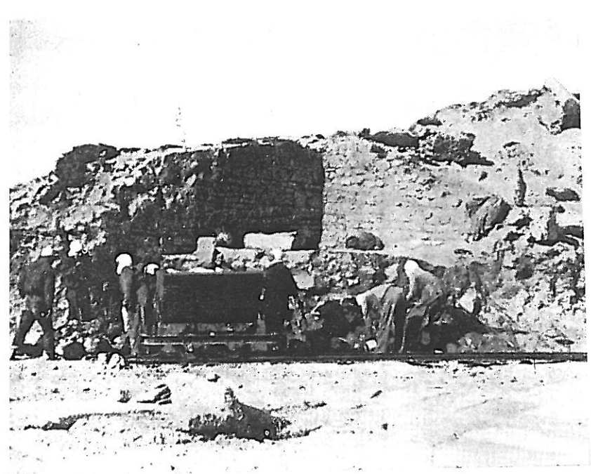
1-2. Costruzioni tarde addossate al Faro.
