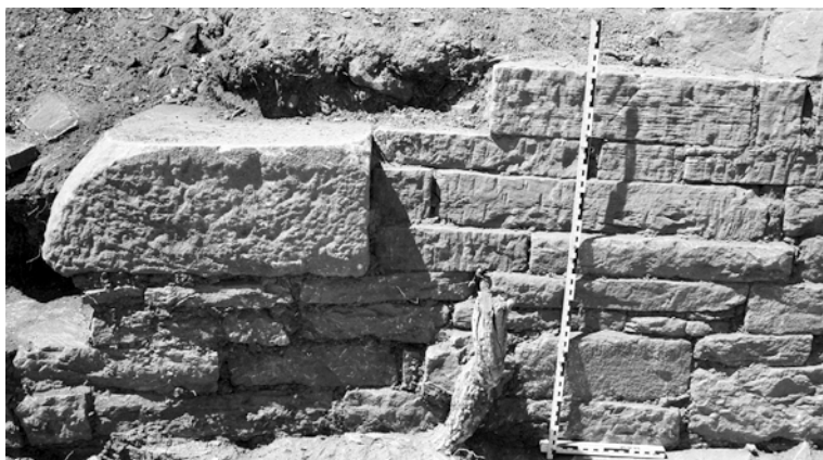
Abb. 27 MYK 139. Archaisches Panionion. Cella-Ostmauer von Osten. Nur das aufgehende Mauerwerk weist eine »Zierspitzung« auf. Links das Unterlager für die nörd- liche Türparastade (vgl. Abb. 54). Foto H. Loh- mann [Di0505.0330].
