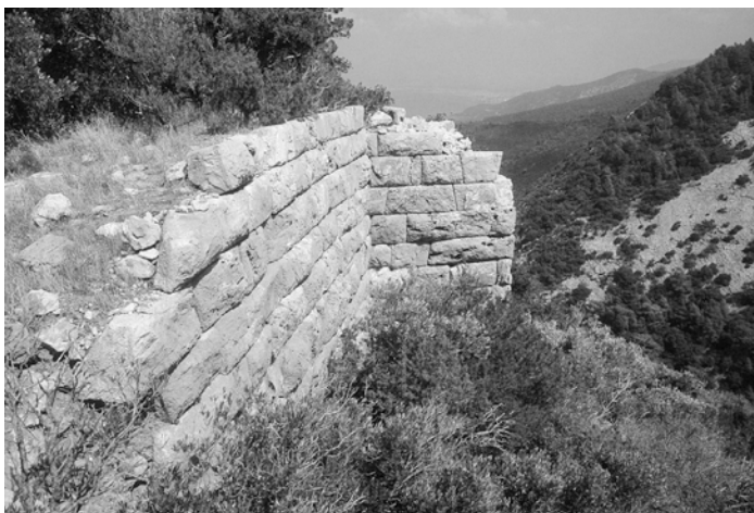
Abb. 14 MYK 70. Mykale-Nord: »Phrourion oberhalb Kalamakibucht«. Jüngere Südmauer mit Bastionen (2. H. 4. Jh. v. Chr.) von Südosten. Foto H. Lohmann [F02.31.31].
