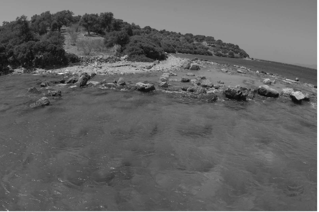
Resim 15: Kuzey Dalgakıranından Görünüm
