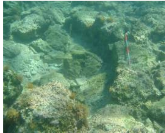
Resim 2: Aperlai- A20 yapısı detay görünüm.
