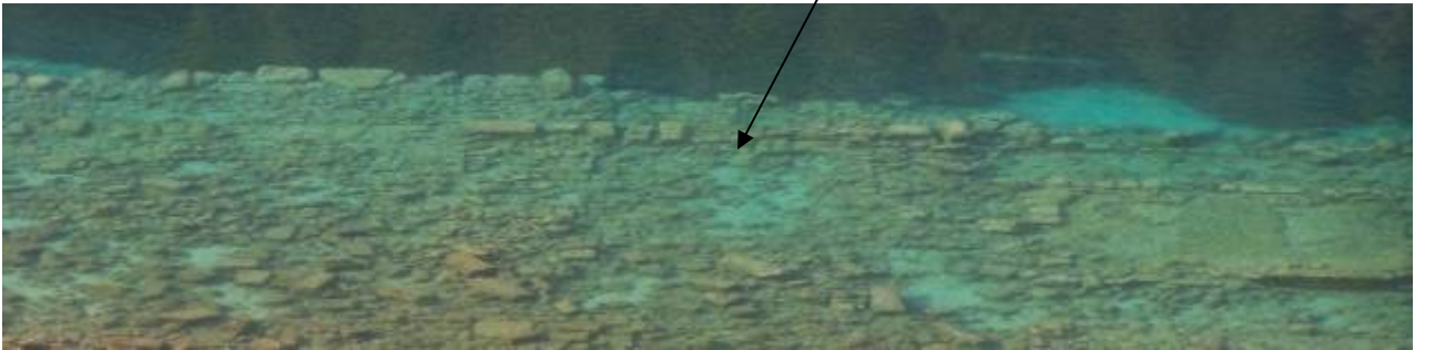
Resim 2: Aperlai- A23 duvarı genel görünüm.
