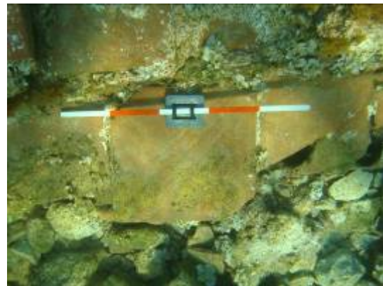
Resim 2: Aperlai- A8 yapısı zemin detayı.
