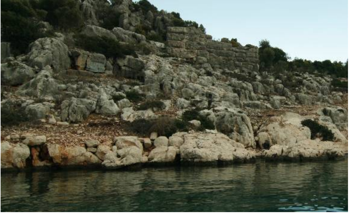
Resim 1: Dolichiste- Tersane Koyu – D28-30 yapısı, güneyden görünüm.
