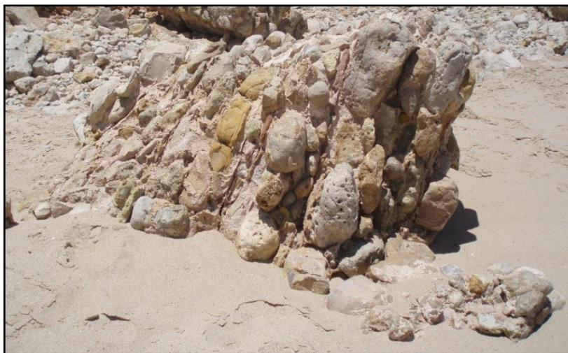
**FIG. 137** Derrube 4 (D4). Canto de um compartimento da frente marítima derrubado (I.E.M.).
