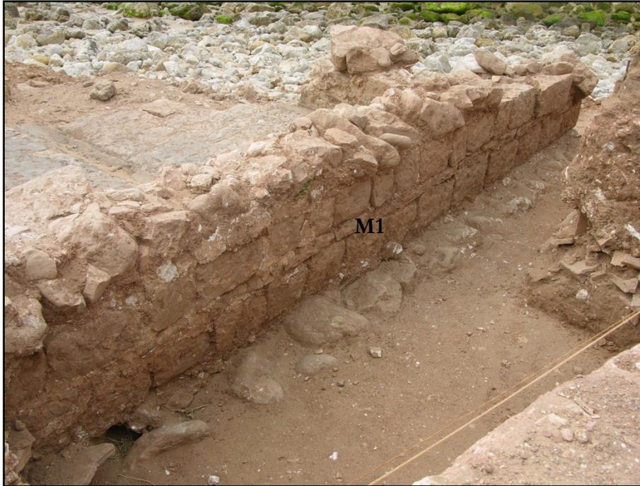
**FIG. 78** Muro M1. Pormenor da sua construção a partir do enrocamento com duas fiadas de blocos calcários bem aparelhados e uma de lajes na horizontal (J.P.B. / I.E.M.).
