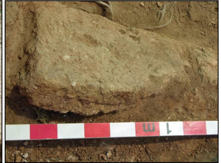
**FIG 48** – Derrube de bloco de taipa (J.P.B.).
