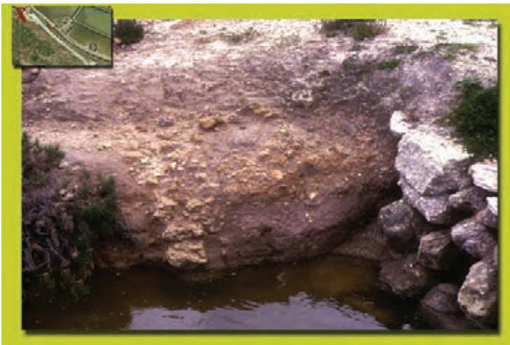
**Figura 20.– Detalle del relleno de la calzada, apreciándose parte del muro lateral Este y fragmentos de piedra ostionera. En el recuadro, su situación.**
