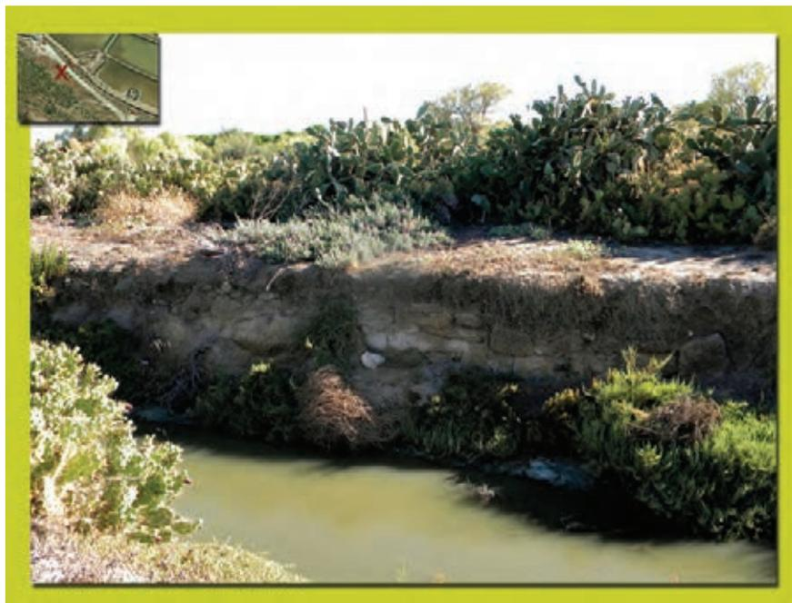
**Figura 15.**– Paramento Este de la calzada. El agua del caño de las salinas ha desprendido la tierra, dejando al descubierto la estructura. En el recuadro, su situación; enfrente, un toruño.
