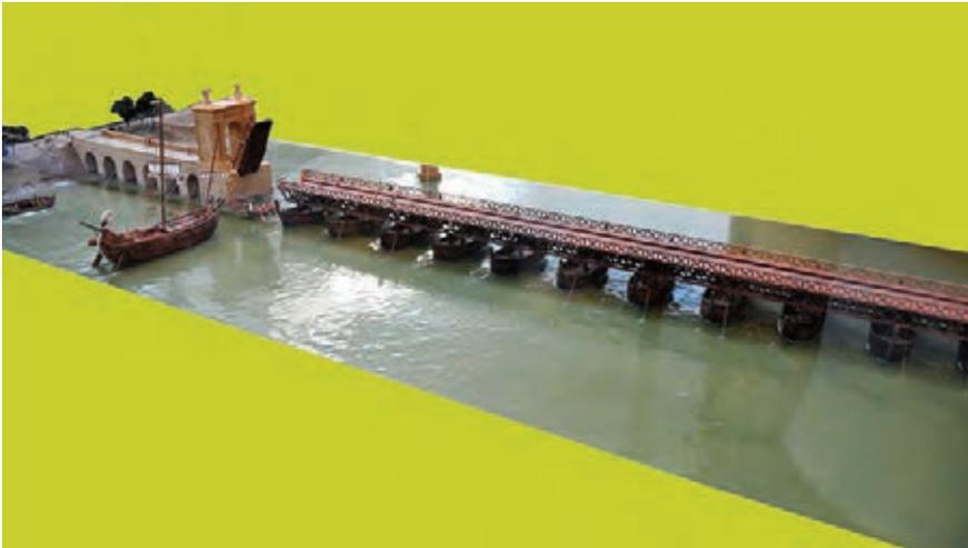
**Figura 6.– Maqueta del puente de barcas de Arlés, en el Ródano, levadizo y con cabeceras de piedra. Fotografía gentileza de Isaac Moreno Gallo (web TRAIANUS.com). Una estructura similar, de menores dimensiones, tendría el que a fines del siglo I a.C. se levantó en el río San Pedro.**
