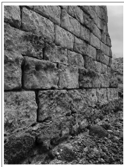
Fig 4. Sillares de la base del puente de Bayyana en el Barranco de San Telmo.
