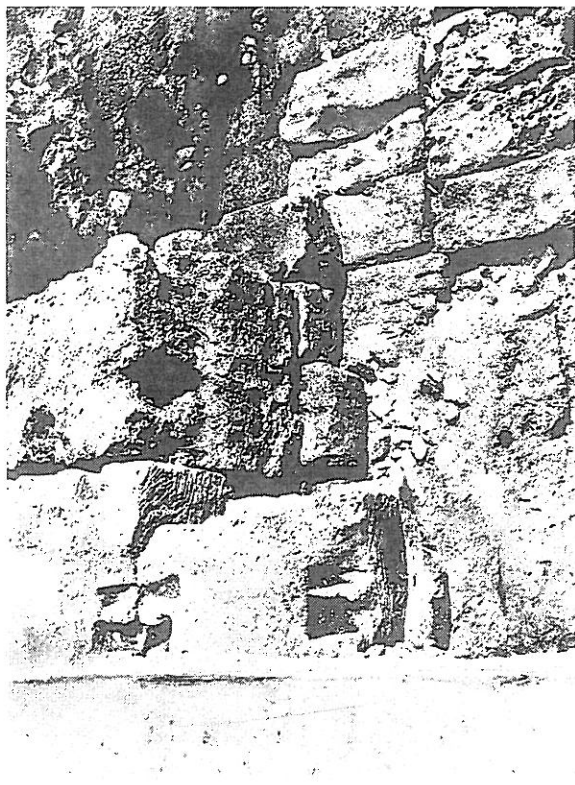
1. - Près du phare. Dans les blocs logements des tenons.
