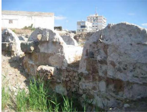
Fig. 26- Citernes, traces d'arrachage de blocs en négatif (photo H. K., Mission de Tyr).
