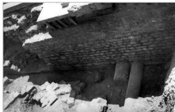
Fig. 41- Tyr, cathédrale, mur de façade, fondations incorporant deux colonnes (Archives DGA)
