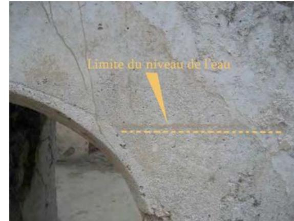
Fig. 31- Trace du niveau d'eau (photo H. K., Mission de Tyr).
