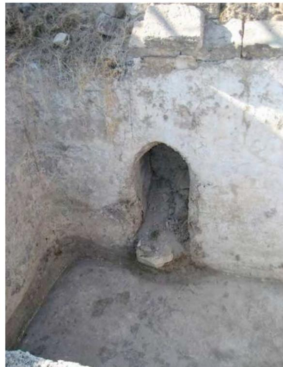
Fig. 29- Ouverture de communication entre deux citernes (photo H. K., Mission de Tyr).
