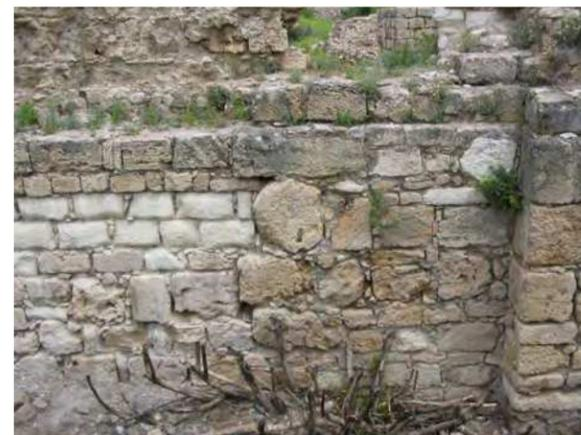
Fig. 43- Tyr, cathédrale, parement extérieur des fondations du mur goutereau sud (photo Mission de Tyr).
