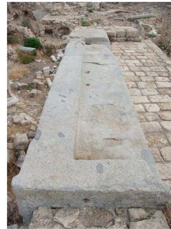
Fig. 68- Cathédrale, seuil de granite de la porte nord (photo A. S., Mission de Tyr).
