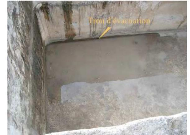
Fig. 32- Orifice d'évacuation au fond de la citerne 12 (photo H. K., Mission de Tyr).
