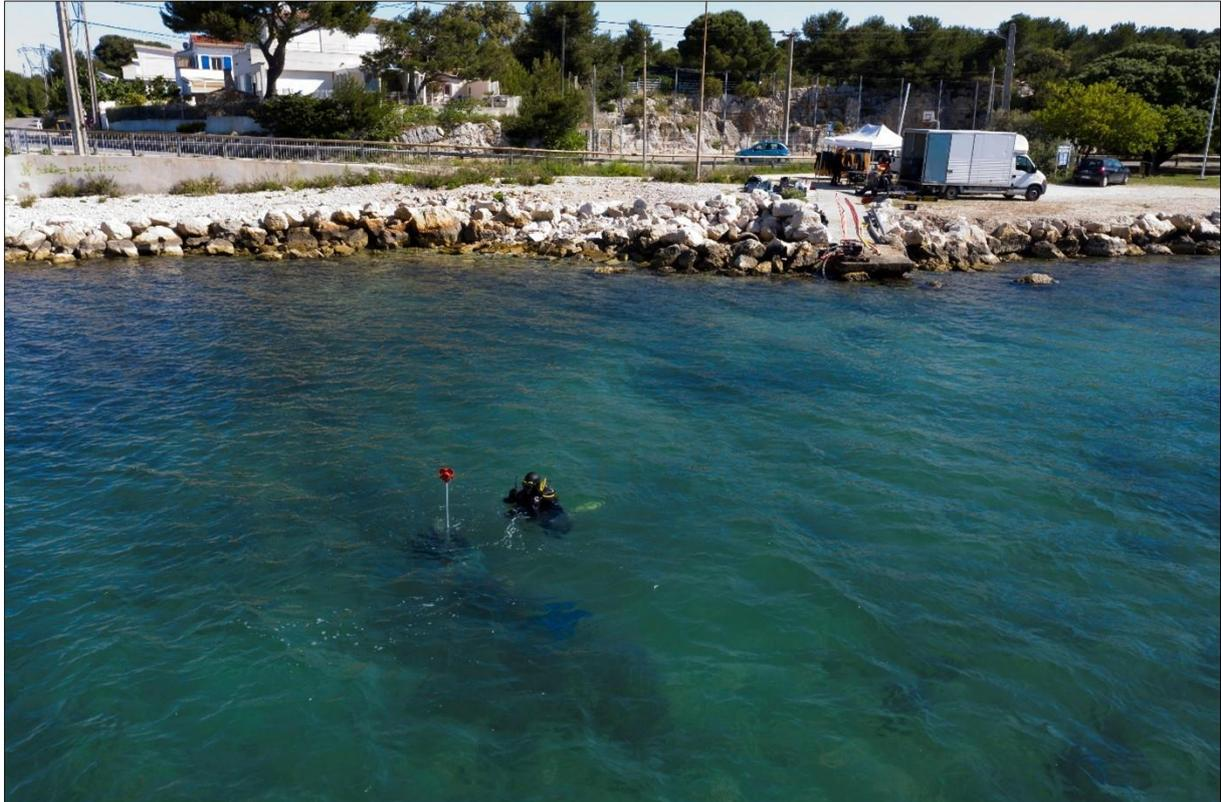
Fig. 11. Levé topométrique aux Laurons en 2021 : les opérateurs sous-marins à la mire topographique © L. Borel – CNRS, CCJ
