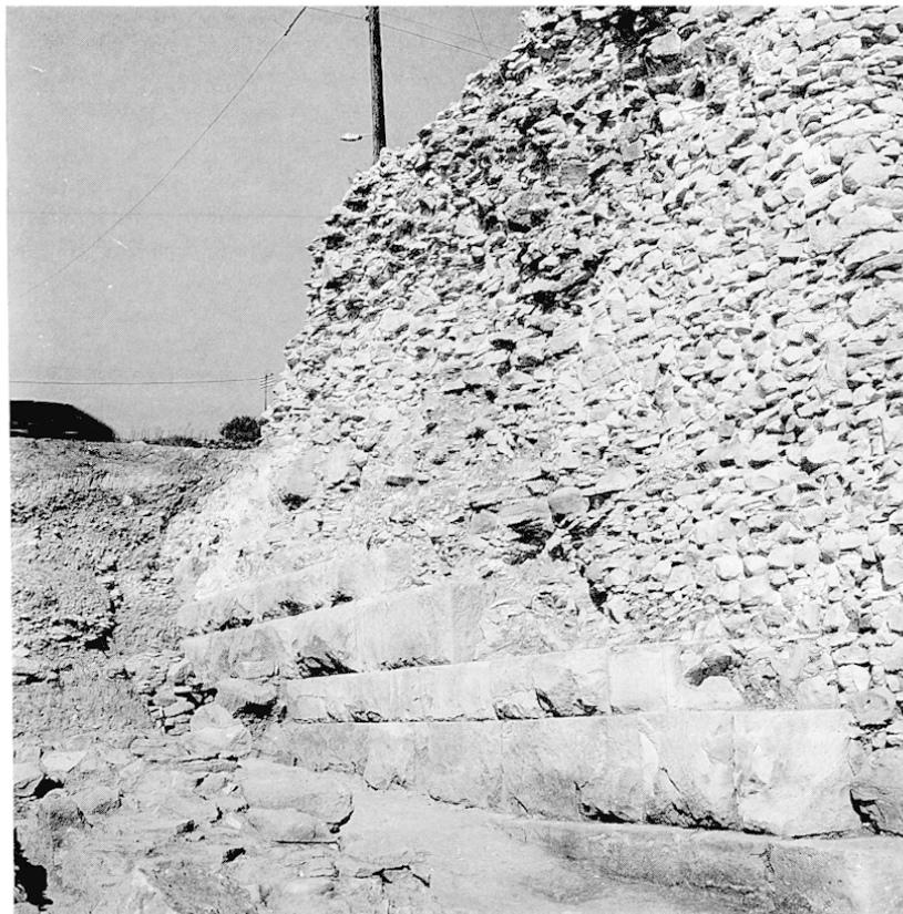
Figure 5. La muraille en bord de mer, détail. Detail of the wall along the shore.
