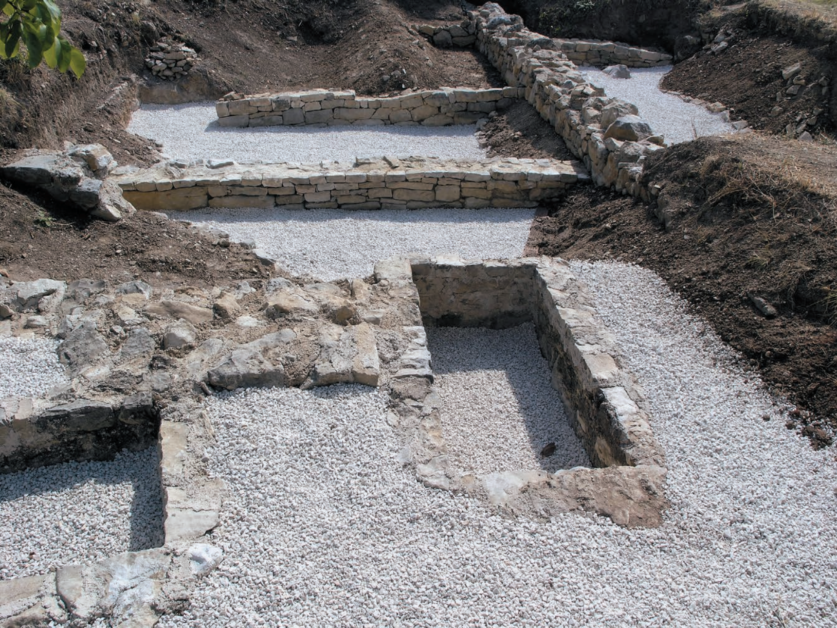
Konzervacija arhitektonskih ostataka iz sonde istraživane 1991-1992. god. Conservation of architectural remains from the 1991-1992 excavations
