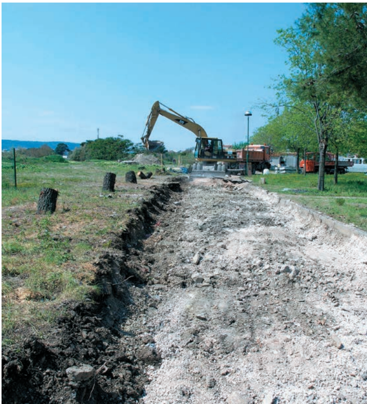
Početak istraživanja 2007. god.-strojni iskop asfaltne ceste Beginning of the research of 2007 – machine excavation of an asphalt road
