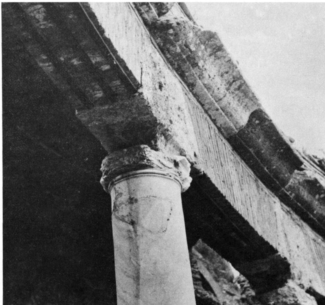
Fig. 8 – Tivoli, villa d'Hadrien, «Théâtre maritime», détail des triples armatures sous-tendant la plate-bande en briques. Photo A.O., 1981.
