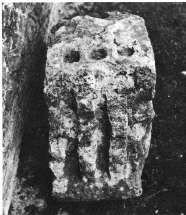
Fig. 4 – Tivoli, villa d'Hadrien. A : sommier d'angle de la «Salle aux piliers doriques». B : sommier de la «Salle aux piliers doriques». C : sommier du «Théâtre maritime». On comprend mieux, au vu de ces photographies, que Durm ait pu être induit en erreur (voir la fig. 10).
