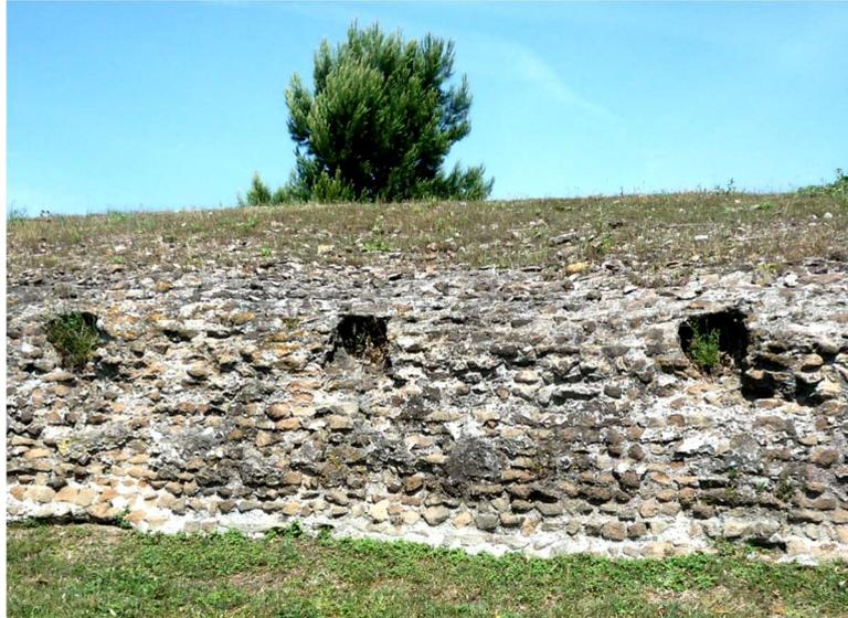
Fig. 1. Brise-lames nord de Portus avec les empreintes des poutres transversales (de Graauw, 2011).
