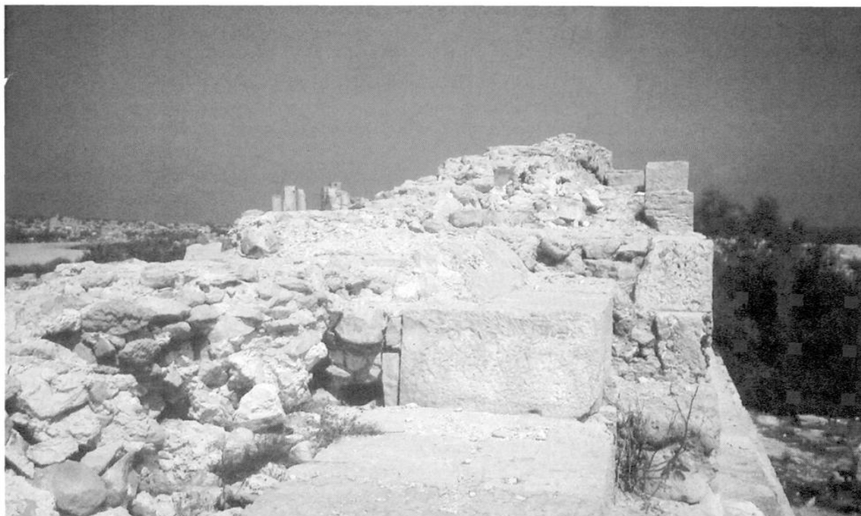
FIG. 2. — Le mur de fond des magasins du môle oriental ; vue prise du sud avec le contact des deux appareils et les solins de mortier hydraulique (photo A. Laronde).
