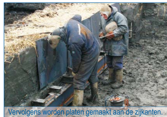
Als alle bodemplaten eronder zijn geschoven wordt ook aan de andere zijde de grond verwijderd. Onder de bodemplaten wordt aan beide zijden een lange dwarsbalk geplaatst.
