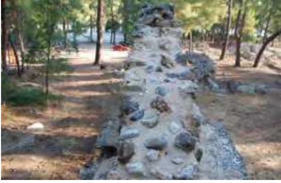
Fig. 113. Moloz Duvarda Gerçekleştirilen Capping Uygulaması
