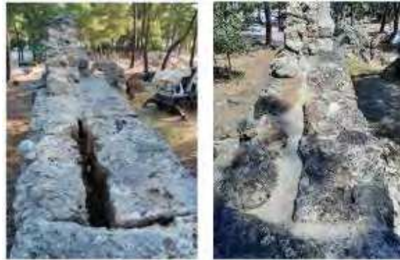
Fig. 112. Yapı Üzerinde Yer Alan Boşlukların Harç ile Doldurulması
