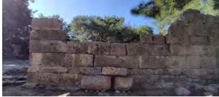
Fig. 106. Uygulamalar Sonrası Duvarın Genel Görünümü
