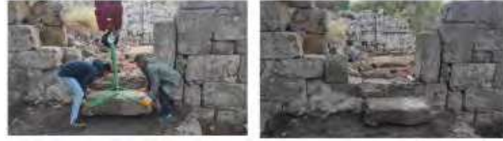
Fig. 104. Kapı Söve ve Eşiğinin Yerleştirildikten Sonraki Görünümü
