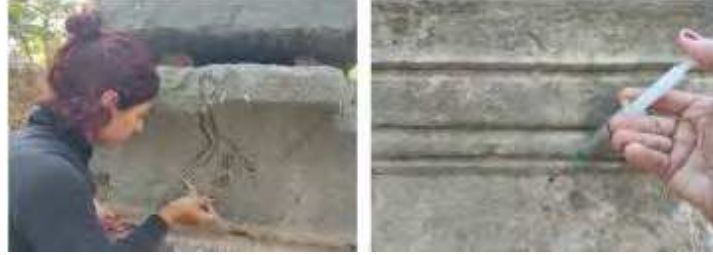
Fig. 103. Enjeksiyon yardımıyla Epoksi Uygulaması
