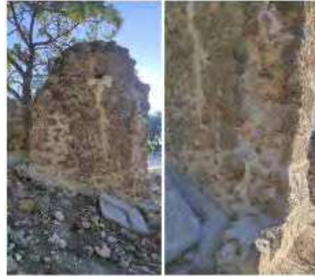
Fig. 102. Uygulama Sonrası Duvarın Batı Cephesi
