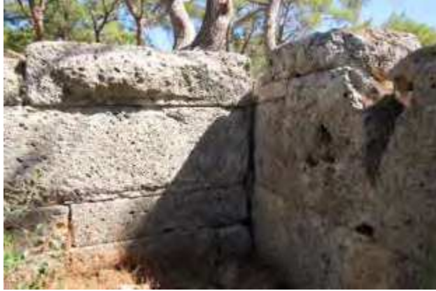
Fig. 32. Kule ile savunma duvarının bağlantı detayı
