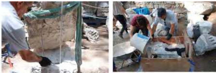
Fig. 98. Bloklara Çelik Pimlerin Yerleştirilmesi ve Bütünleme Harcının Dökülmesi
