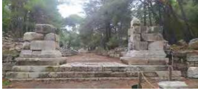
Fig. 99. Blokların Orijinal Yerlerine Yerleştirildikten Sonraki Görünümü (Güney Cepheden)
