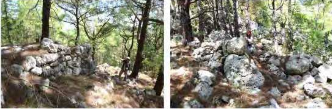
Fig. 61. Yapıya ait duvar kalıntıları
