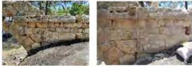
Fig. 111. Derz Uygulaması Öncesi ve sonrası
