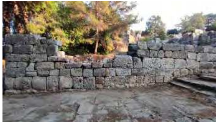
Fig. 105. Uygulama Tamamlandıktan Sonraki Görünüm
