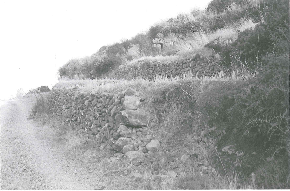
Res./Fig. 6 Güney Yamaçtaki Dış Sur External fortification walls on the south slope
