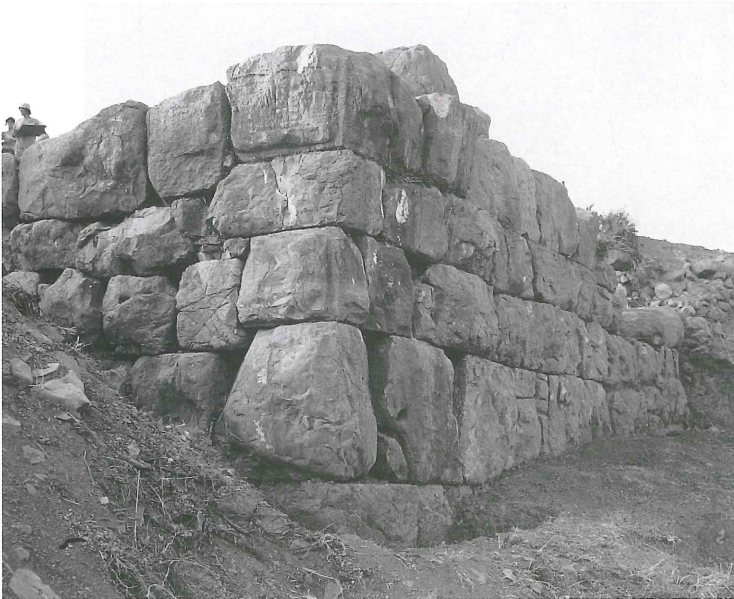
Res./Fig. 12 Kule 4 Tower 4
