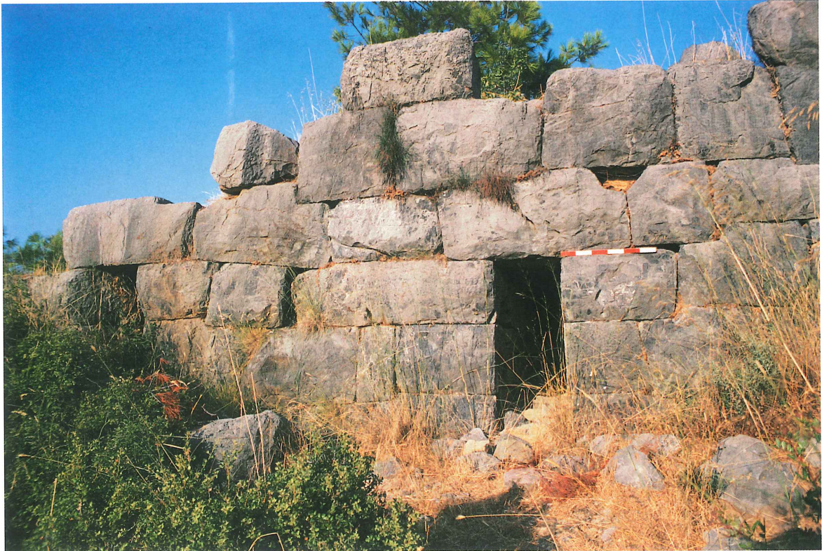
Res./Fig. 14-15 Kule 3 Tower 3
