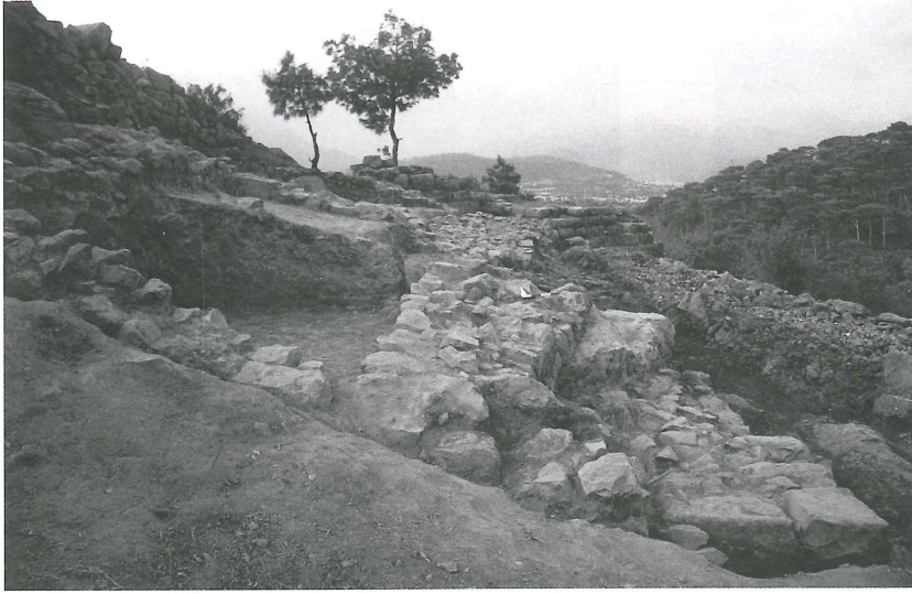
Res./Fig. 26 Kule 1 ve kule 2'nin sağlamlaştırılması Reinforcement of Tower 1 and 2
