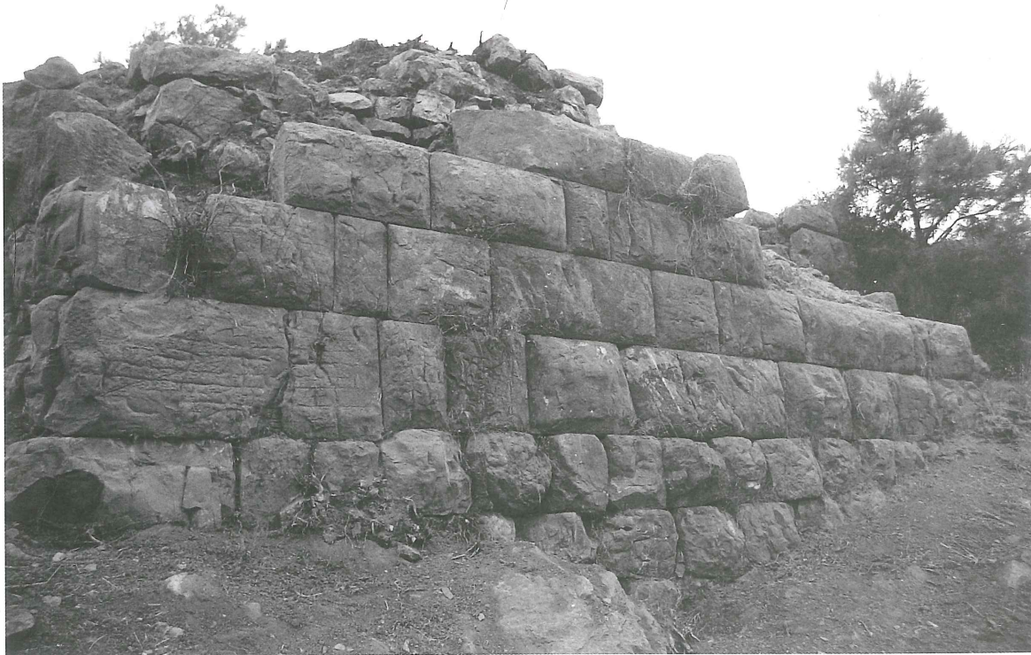
Res./Fig. 7 Kule 1 ve Sur Duvarı (TU-34 ve T-34) Tower 1 and fortification wall
