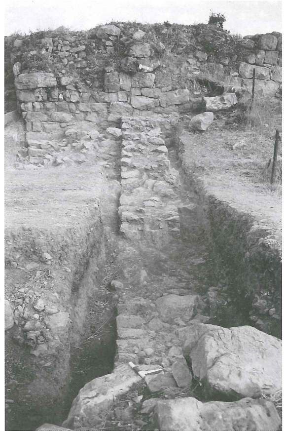
Res./Fig. 13 Kule 2 ve Kule 3 Arasındaki Bağlantı Duvarı Connecting wall between Tower 2 and Tower 3
