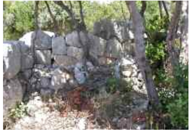
Fig. 6: Polygonal duvarın düz yüzeyli bölümü.
