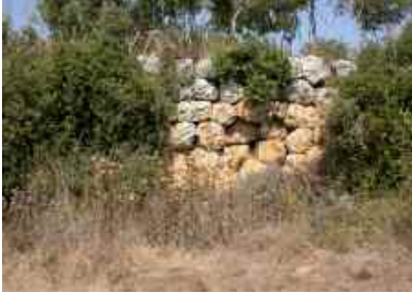
Fig. 3: Polygonal duvarın güneybatı cephesinden bir görünüm.
