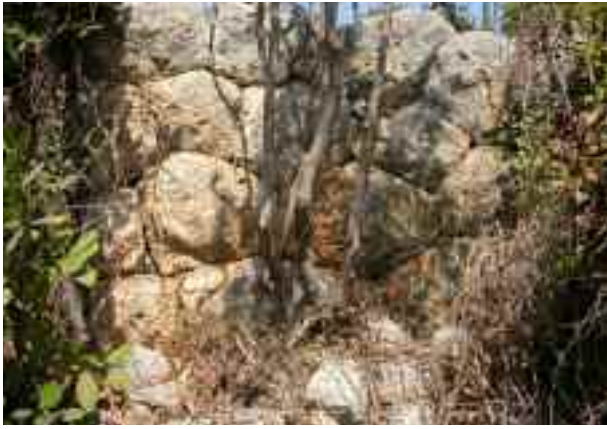
Fig. 5: Polygonal duvarın güneybatı cephesinden bir görünüm.
