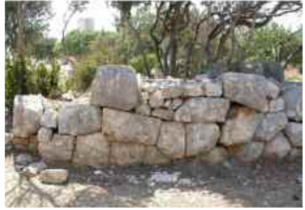
Fig. 4: Polygonal duvarın kuzeydoğu cephesinden bir görünüm.
