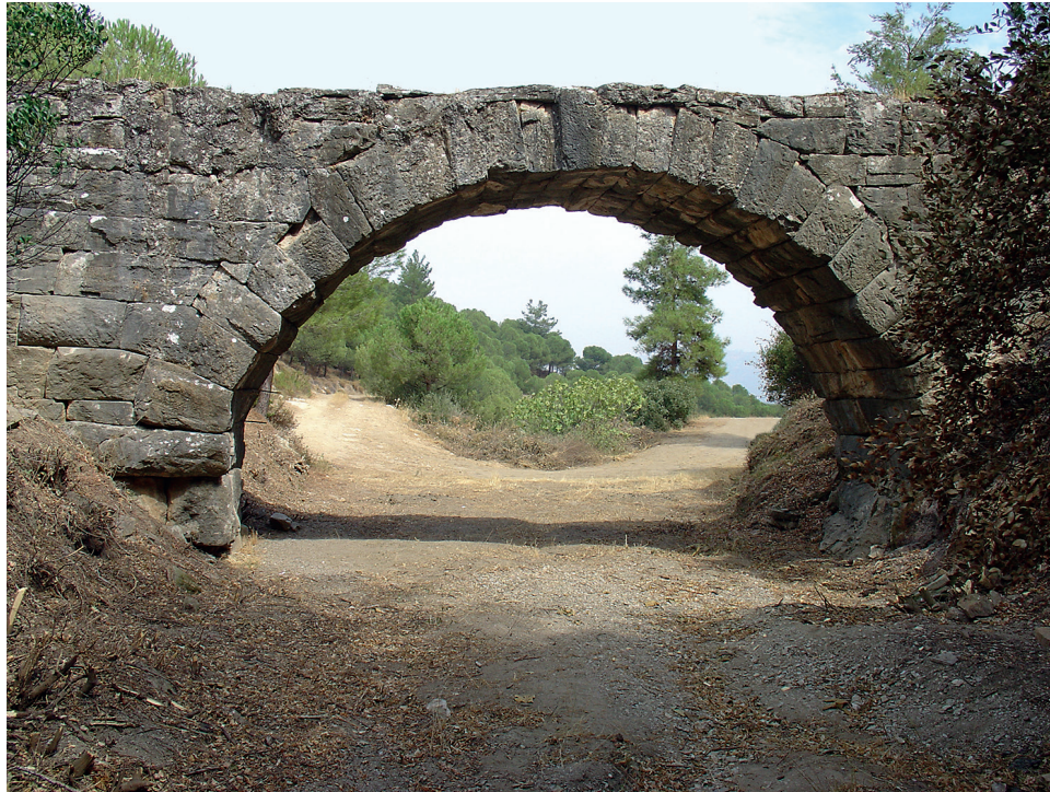
15 Hellenistische Aquäduktbrücke der Aqua Throessitica
