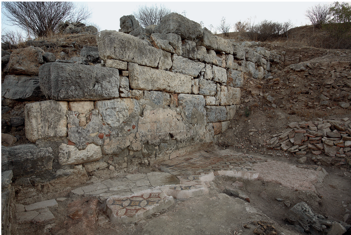
13 Hellenistische Befestigungsmauer auf der sog. Ionischen Akropolis mit spätantiken Anbauten
