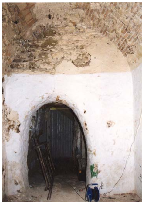
Lámina VI. Aljibe interior de la Torre del Homenaje.
