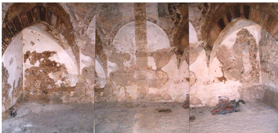
Lámina VII. Interior de la primera sala, antes de la restauración.
