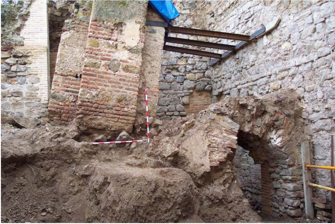
Lámina VII. Excavación del pilar.
