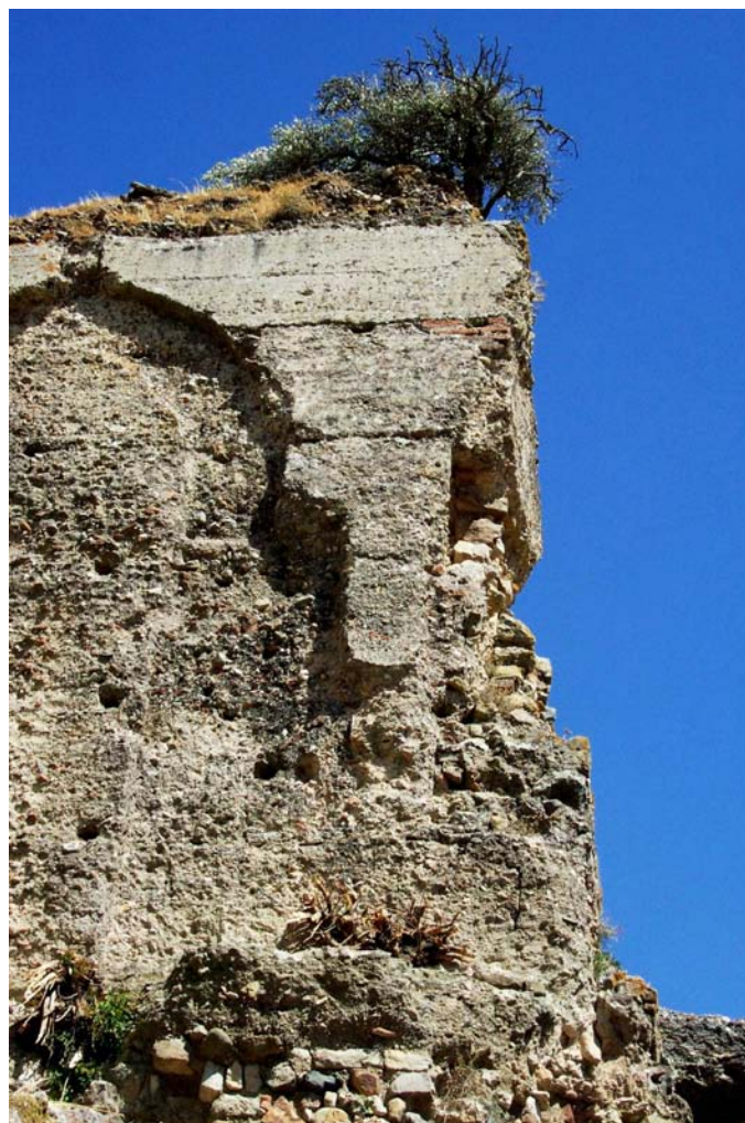
Lámina II. Detalle de la segunda planta de la torre del homenaje.
