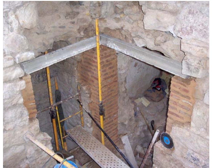
Lámina XVII. Labores de consolidación.
