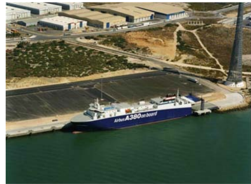
Lámina IV. Vista final de las obras.
