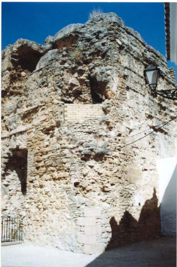
Lámina V. La Torre del Homenaje antes de su restauración.
