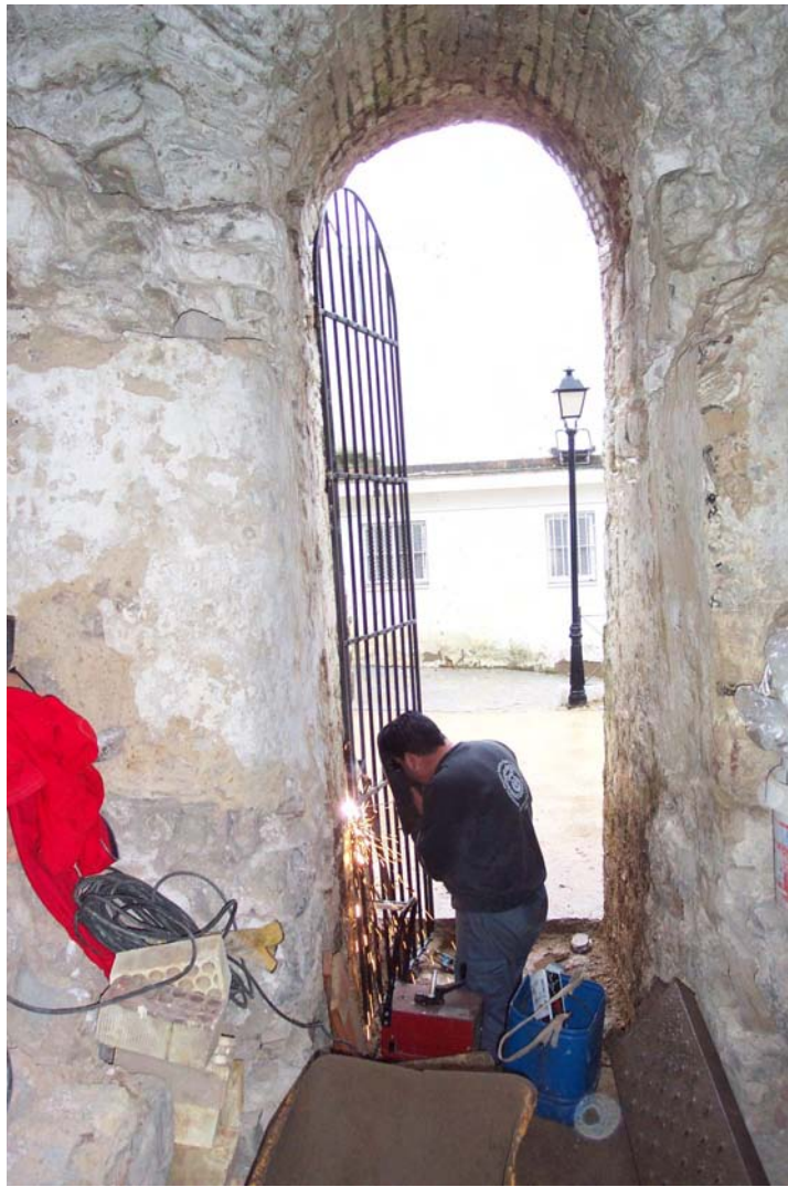
Lámina XVIII. Mejoras en el cerramiento de la torre.
