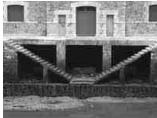
Fig. 13. Detalle del frente del tablestacado de madera y de las cimentaciones de la casa de vecinos
