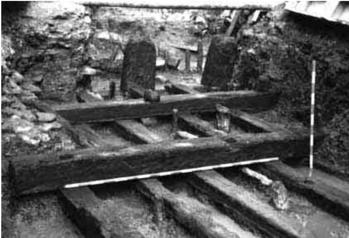
Fig. 9. Detalle de la estructura de madera del varadero del puerto romano de Santiago
