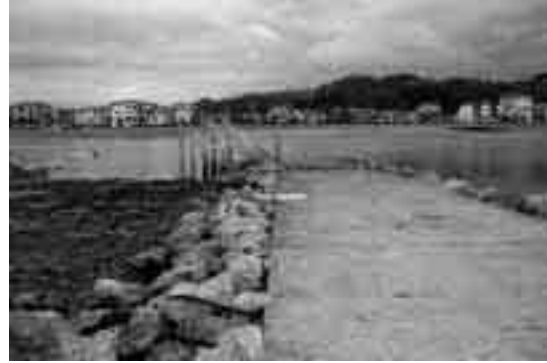
Fig. 17. Detalle del muelle
