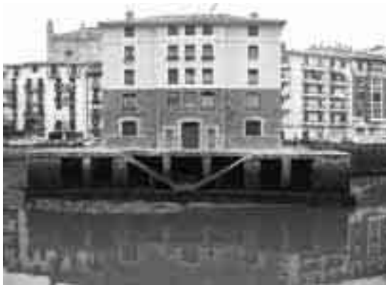
Fig. 12. Tablestacado de protección de la cimentación de una casa de vecinos en la ría de Ondarroa
