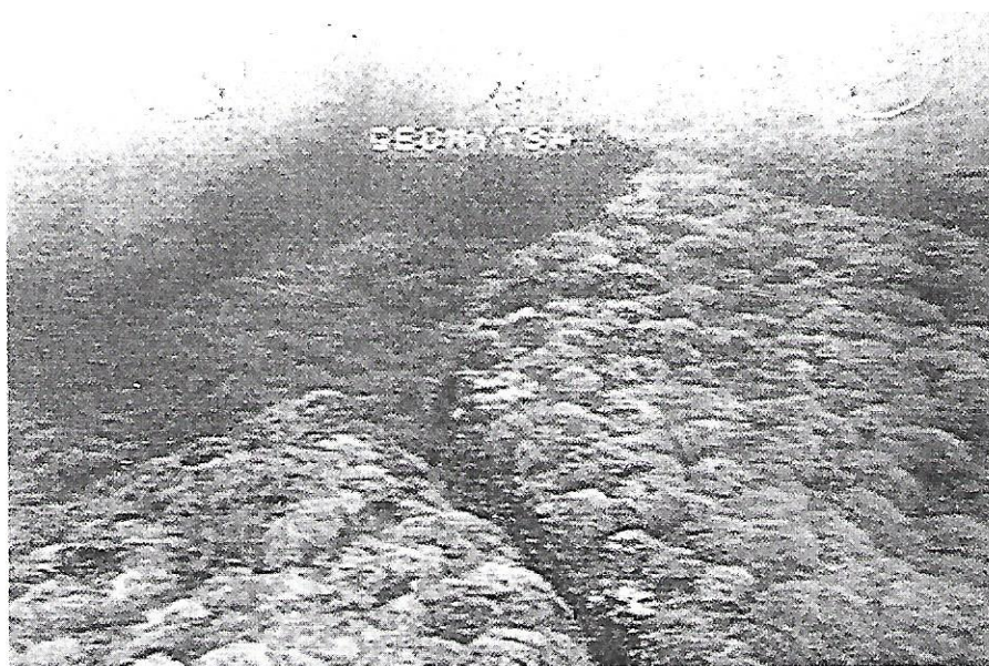
Arriba: En esta fotografía puede intuirse el arranque del dique, siguiendo en el agua la línea imaginaria que marcan las olas rotas, pues un cambio brusco de la profundidad del mar por la presencia de cualquier obstáculo provoca una rotura del oleaje diferente a la que tendría de no existir aquél. A la derecha: Fotografía submarina de la Laja tomada en 1993 en la que se ven bloques que forman la obra.
