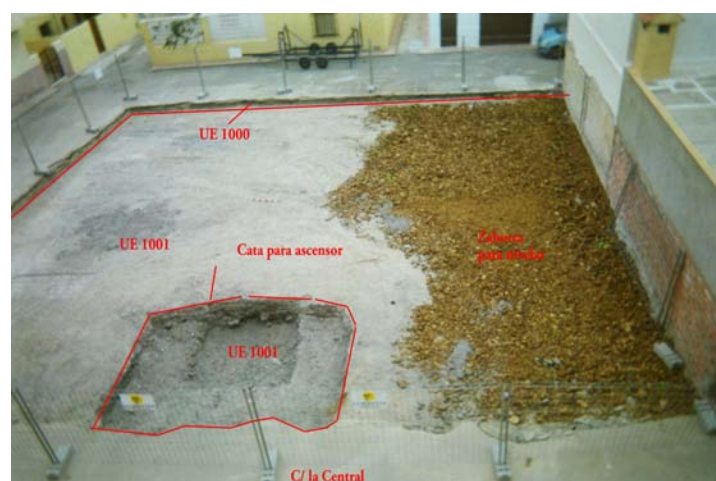
Lámina III. Solar tras la excavación
