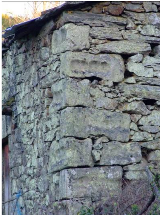
Bases de molinos de impacto múltiples reutilizados en las construcciones de la aldea de Ribeirinha
