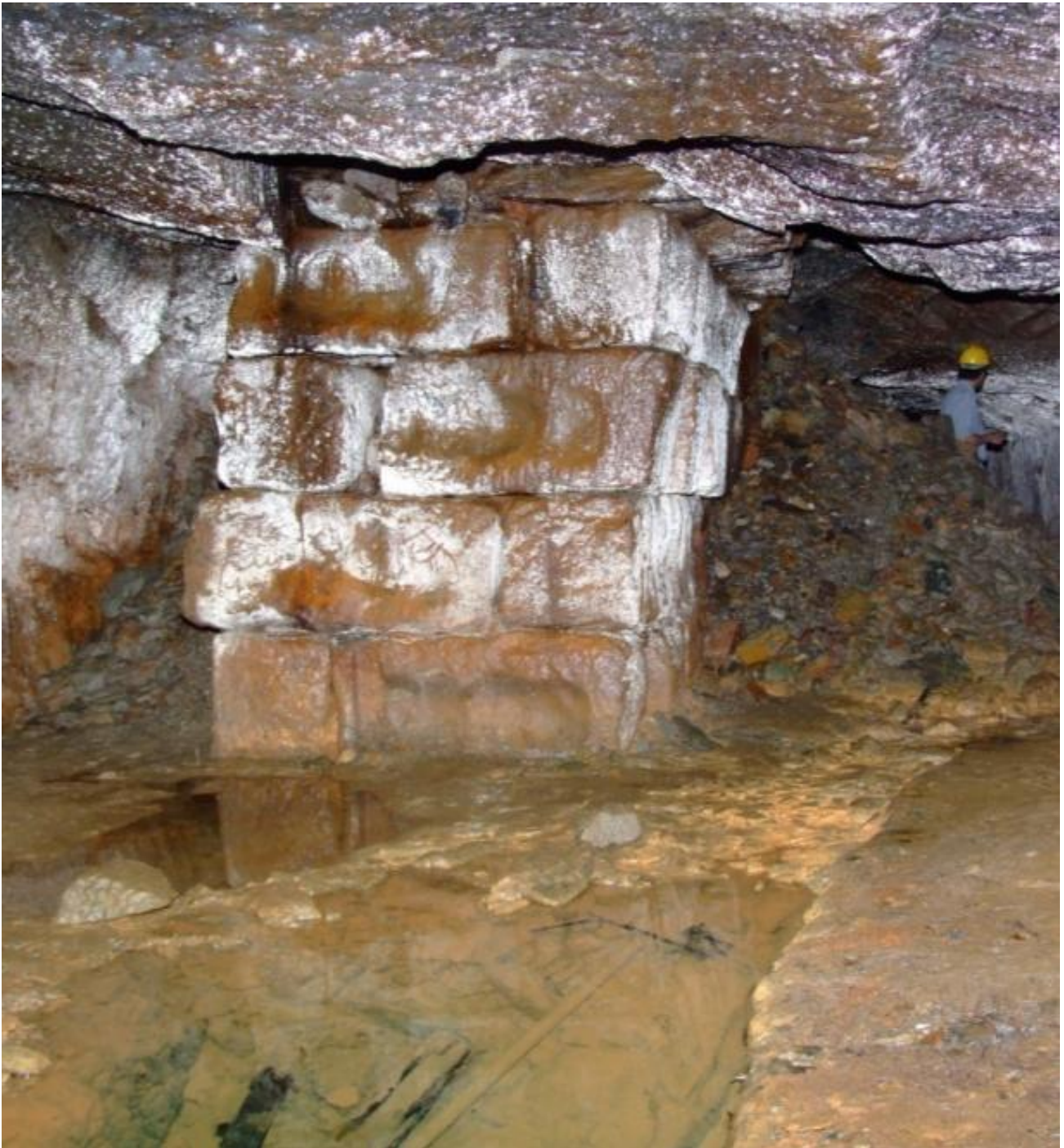
Pilar realizado con bases de molino de impacto múltiples que da nombre a la galería donde se encuentra (Galería do Pilar-Corta de Covas). Tresminas
