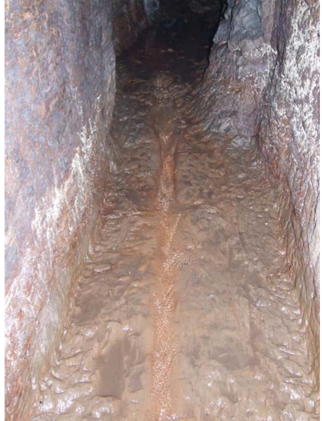
Canal de desagüe en el fondo de la galería (Banjas-Paredes)
