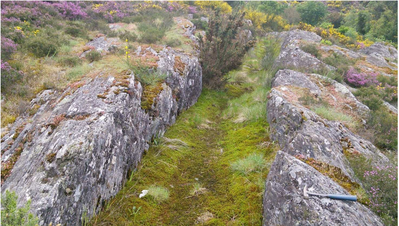
Figura 4: Parte preservada do aqueduto mineiro cravado em negativo na rocha, com uma largura de 1,20 metros.
