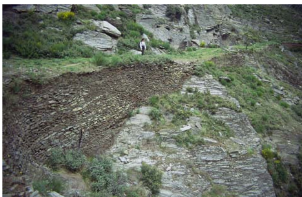
Muro de sustentación de un canal romano
