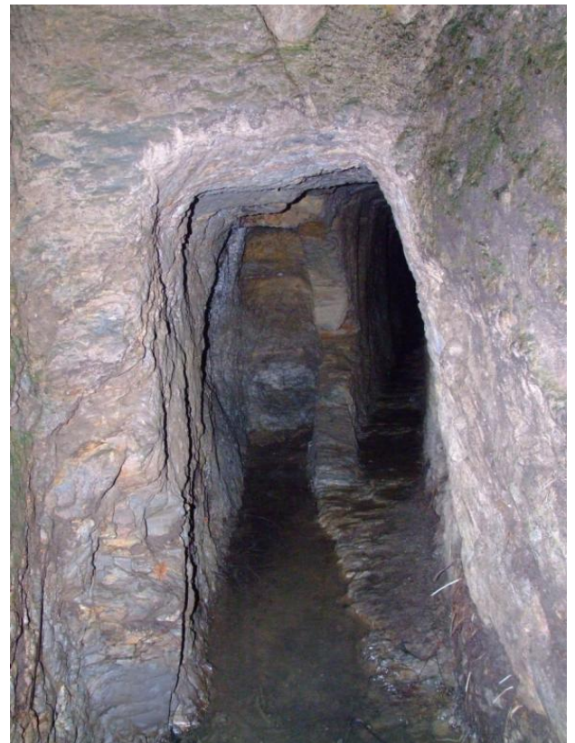
Encuentro de galerías en la G-1 (Valongo)
