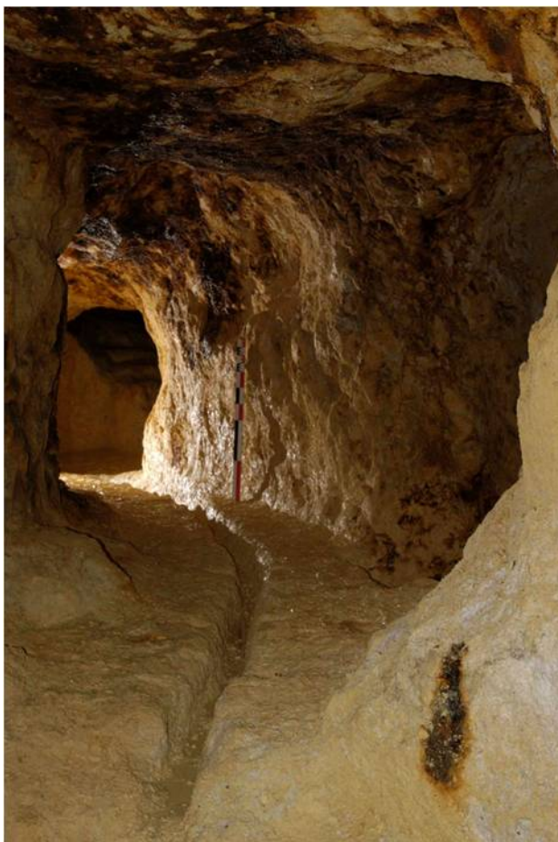
Galería con canal de desagüe central (Cauuet, 2008)
