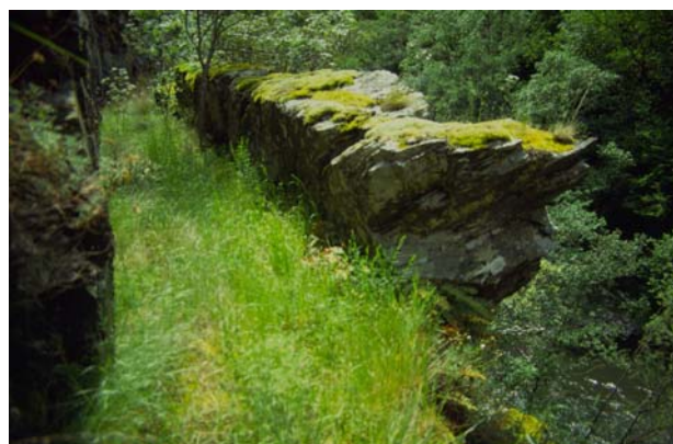
Corte en la roca de un canal de abastecimiento
