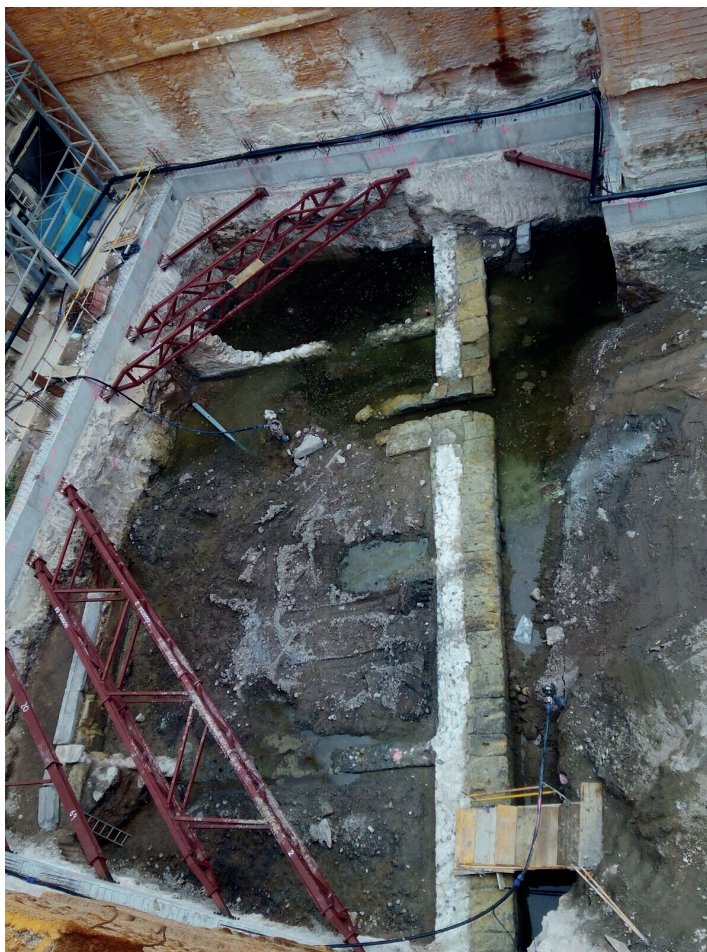
Fig. 10.- Imagen del hallazgo del cantil de muelle de época romana. En primer plano cantil en arenisca, refuerzo de caementicio y tirantes transversales al mismo. Nótese en el ángulo inferior izquierdo, los zócalos en caliza de las estructuras de almacén. Fotografía del autor.
