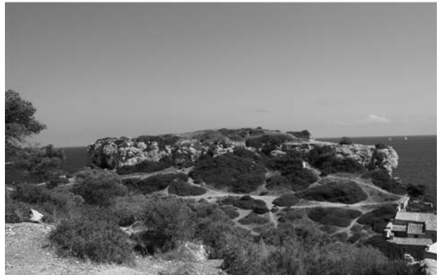
Fig. 10. Morro costero de S'Almúnia (Mallorca), sobre el que se conservan restos de fortificaciones.
