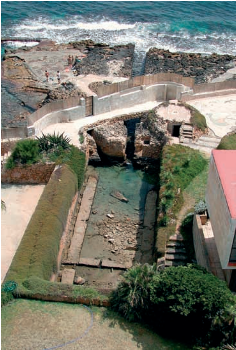
Figura 4. Vista actual de la piscina y de los canales de comunicación con el mar de Punta de l'Arenal. Foto Museu Arqueològic de Xàbia
