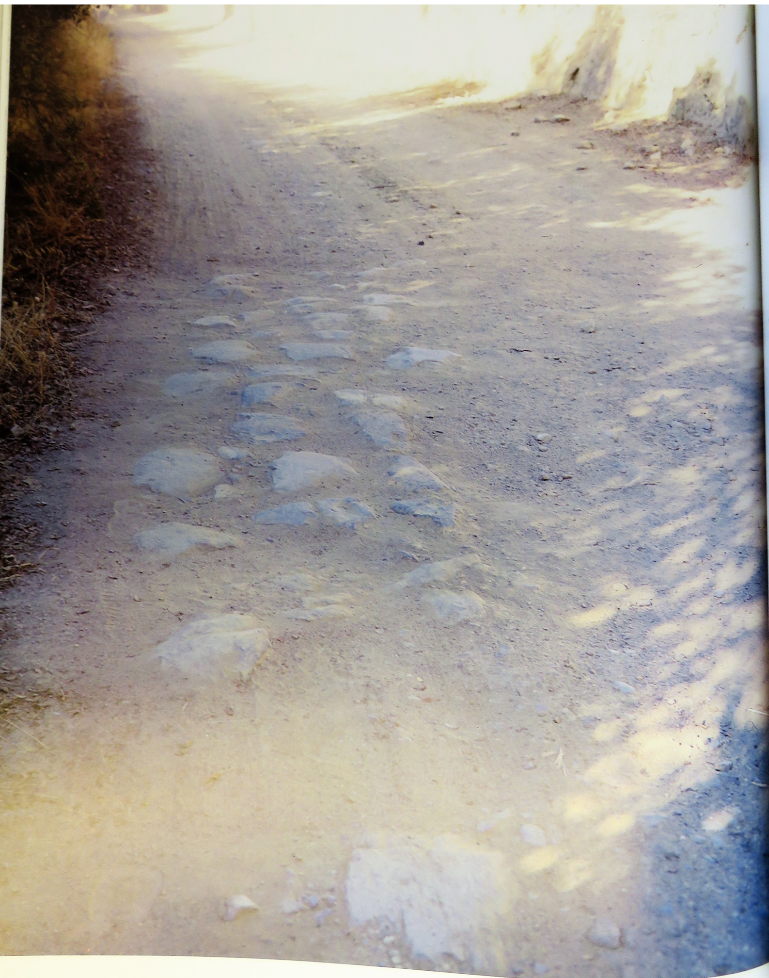
Calçada do "Caminho do Concelho" (Pedras d'el Rei)
