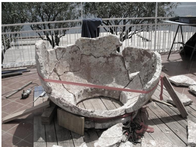
La reconstruction en cours
