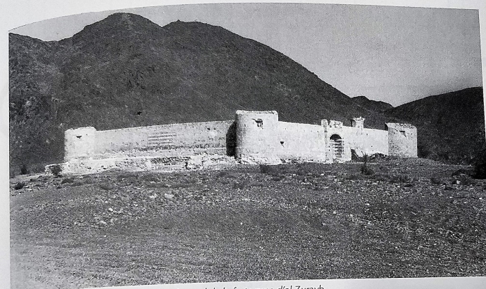
Fig. 96a. Al-Wajh. Façade d'entrée et façade nord de la forteresse d'al-Zurayb.
