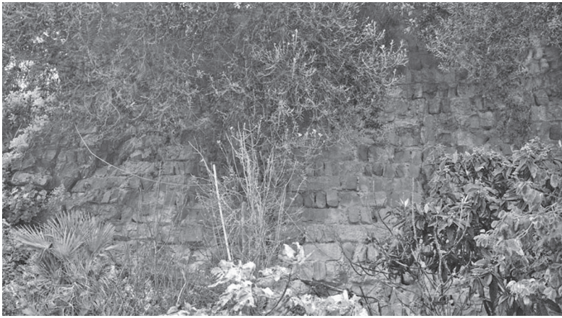
FIG. 3. – Vue de l'enceinte urbaine de Tanger.
