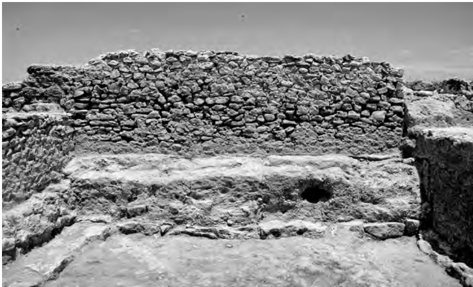
Fig. 5 — Mur nord de la salle 4. Du bas vers le haut apparaissent : la fondation faite de moellons de calcaire, en léger ressaut par rapport à une assise de blocs de grès, sur laquelle prend appui l'élévation appartenant au type 2A. Ce dernier associe un blocage fait de petits moellons de calcaire liés par du mortier de chaux et des harpes montées en bloc de grès, contre lesquelles prennent appui les refends (cl. 572).
