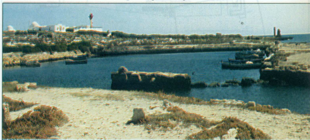
Fig.6 : restes de la roche mère et des blocs de maçonnerie appartenant au mur qui prolongeait la passe à l'intérieur du bassin
