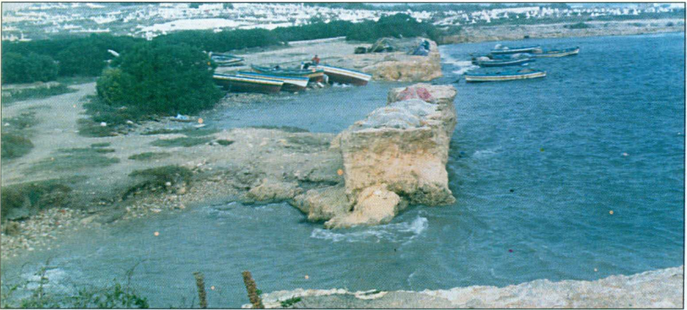
Fig.9 : les ouvertures du présumé second bassin
