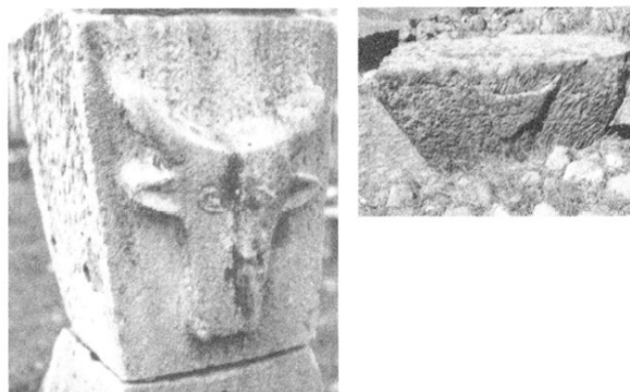
Fig. 219 – À gauche, claveau orné d'un bucrâne conservé dans la cour d'une maison de Sidi-Ghilès. À droite, reste d'un décor analogue (?) sur un claveau de la villa de Bou-Alem (n° 191).
