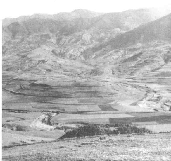
Fig. 176 – Le bassin des Touares et le site d'Icherène vus depuis Rardous. Les banquettes qui soulignent les courbes de niveau ont été aménagées, à une époque tout à fait récente, contre l'érosion des sols. Les points noirs visibles sur le sommet de l'éperon sont les harpes qui abondent sur le site (cf. infra , fig. 177).
