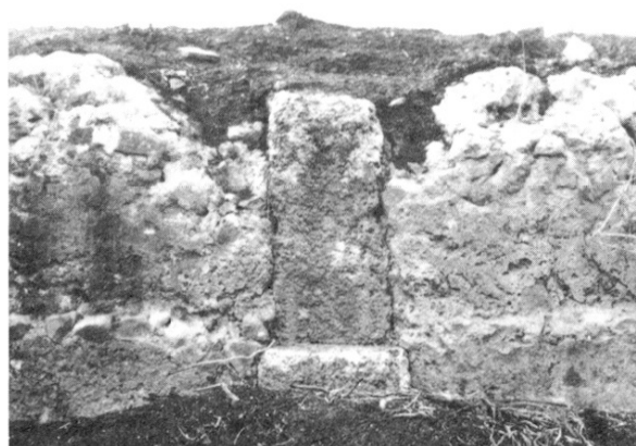
Fig. 217 – Mur en opus africanum soutenant la terrasse de la villa de Bou-Roukht (n° 30, p. 265).
