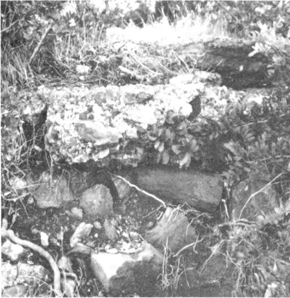
Fig. 234 – Coupe de la plate-forme de pressoir du site n° 20 : en bas, de gros blocs de pierre sur une épaisseur d'une quarantaine de centimètres; puis une forme de mortier grossier d'une dizaine de centimètres d'épaisseur; au-dessus, l' opus signinum lui-même, que la végétation masque en partie.
