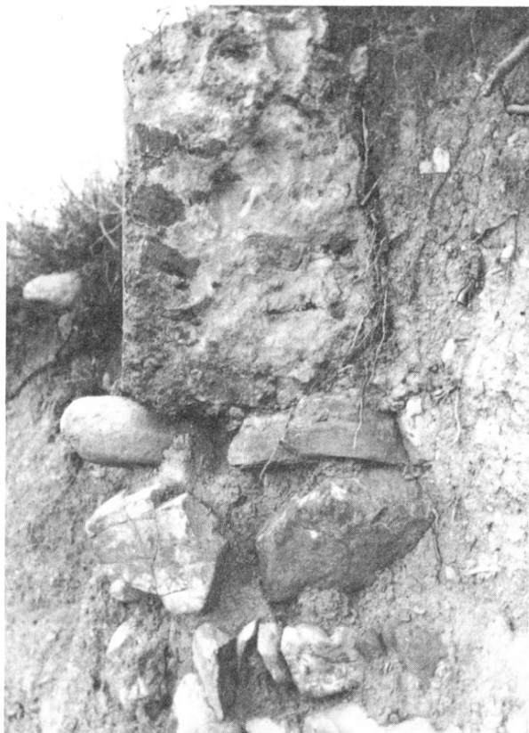
Fig. 218 – Mur de blocage sur tranchée de fondation remplie de galets d'oued (n° 232).
