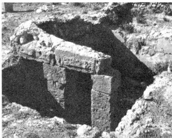
Fig. 226 – Citerne ou bassin réutilisé dans une construction postérieure aux Trois-Îlots. Au nord (vers la mer), on aperçoit deux des bassins de salaison (n° 12).
