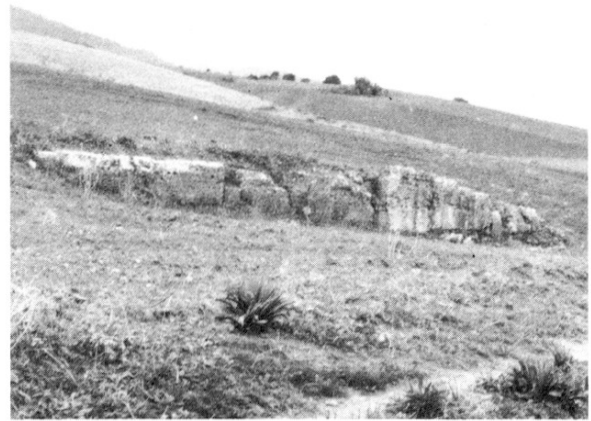
Fig. 92 - Le mur sud de la villa de l'oued el Hammam (n° 69).
