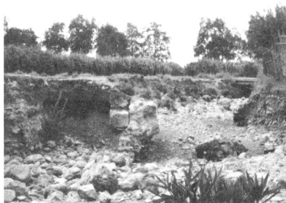
Fig. 96 – Massif de maçonnerie paraissant correspondre aux ruines d'un pont sur l'oued Sidi-Ghilès.
