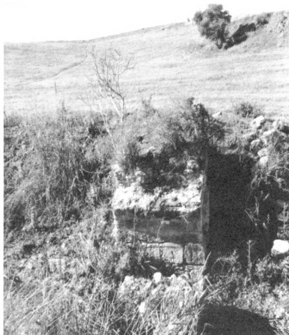
Fig. 48 - Le pont sur l'oued Rassoul : la culée ouest.
