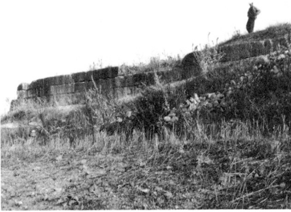
Fig. 80 – Mur en grand appareil renforcé de boutisses de la terrasse sur laquelle était construite la villa de la Zaouia de Sidi-Moussa (n° 54).
