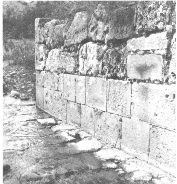
Fig. 194 – Id. On voit le radier sur lequel coule encore l'oued et la différence d'appareil montrant une reconstruction de l'ouvrage au dessus de la seconde assise.
