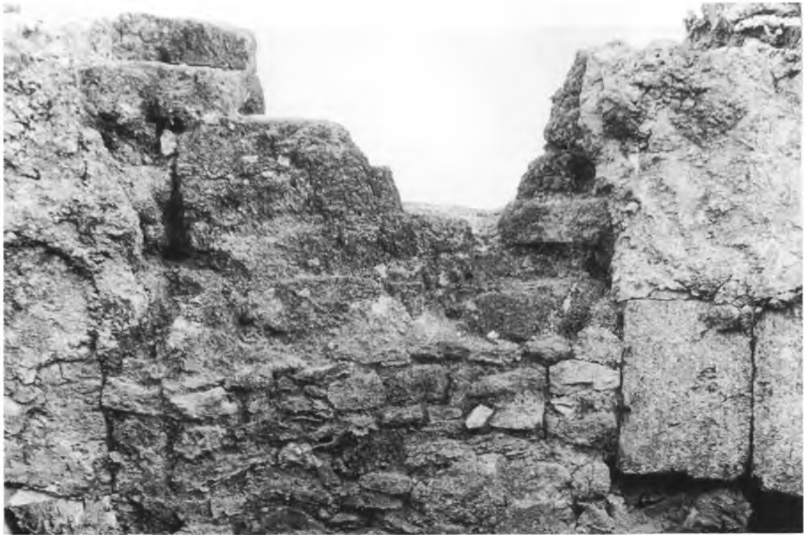
Photo 1. Porte volontairement obstruée entre 29 et 30, donnée comme ouverte dans le plan publié dans Ugaritica IV.
