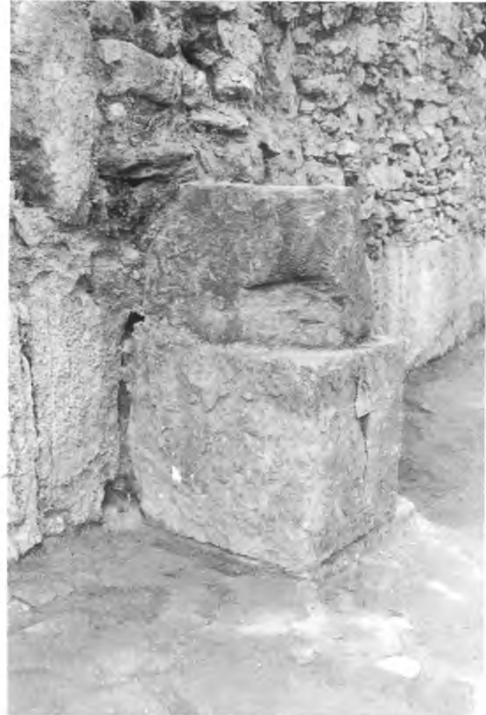
Photo 12. Montant méridional de la baie 78-77. On distingue la trace laissée par le niveau du sol supérieur.
