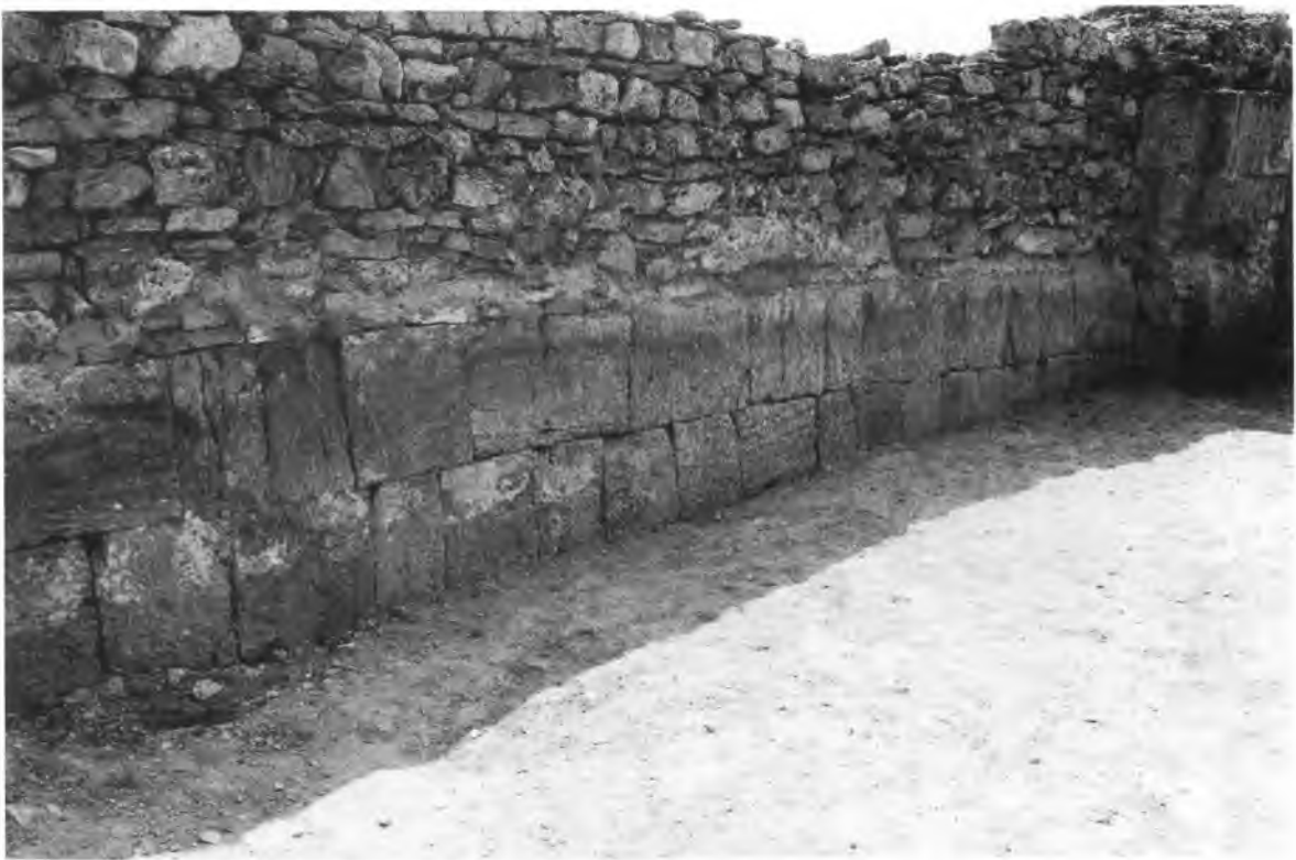
Photo 10. Détail de ces traces d'incendie, blanches ou rouges. Elles indiquent l'existence d'un lambris ou d'une banquette, installés le long des murs.
