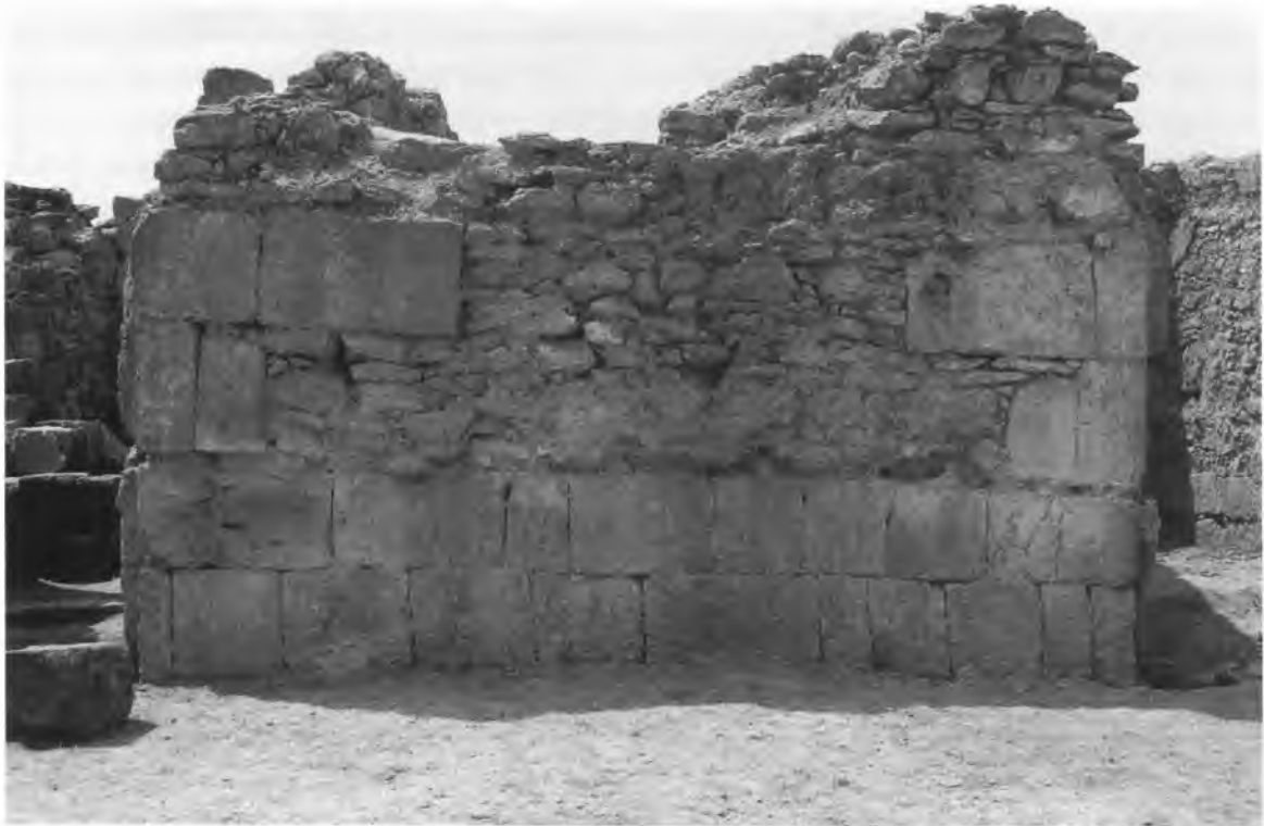
Photo 7. Mur méridional de la salle du trône 71.
