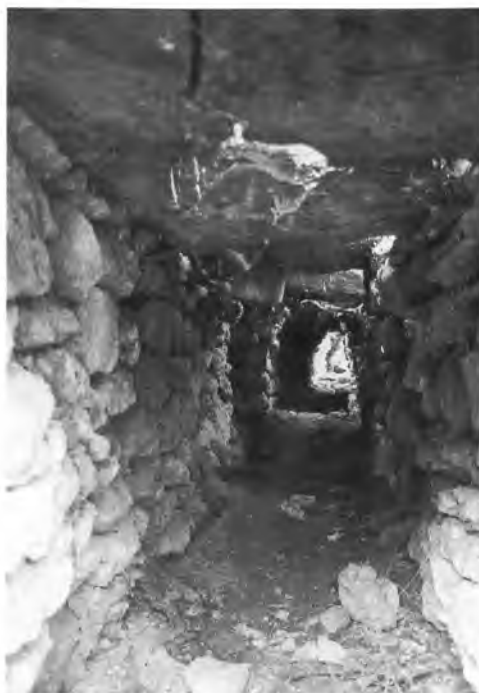
Figure 11. Égout collecteur vu de l'intérieur (mai 1986).
