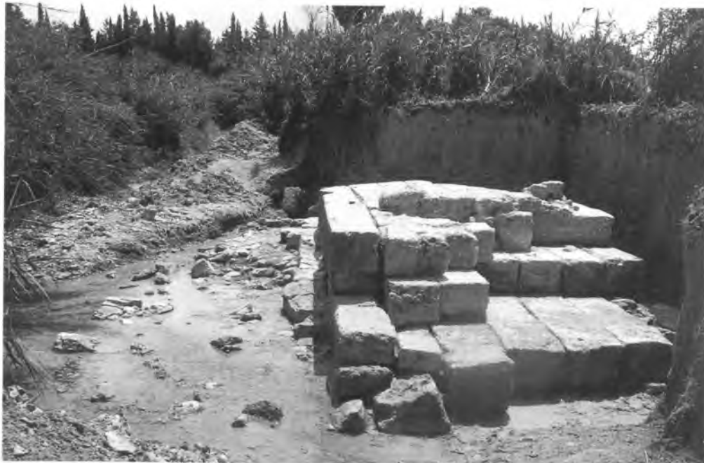
Figure 13. Pile du pont-barrage du nahr ed-Delbé, vue de l'aval (mai 1992).
