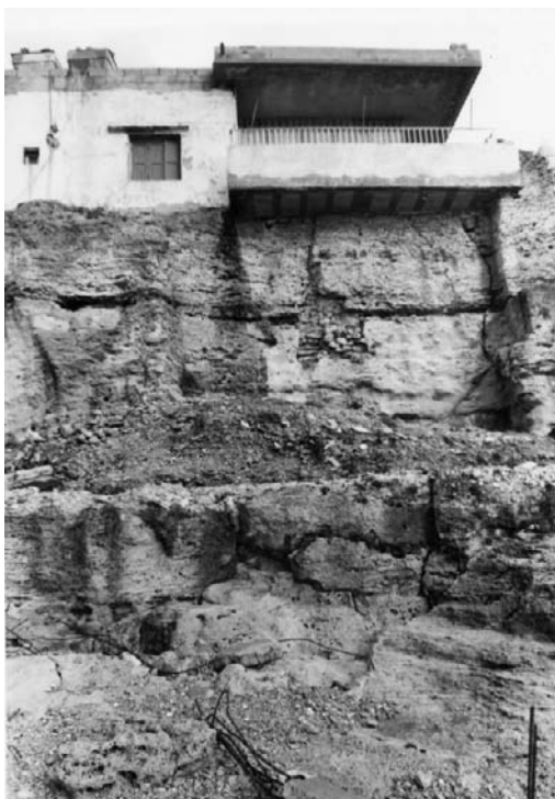
PHOTO 6 - BATROUN : VUE DES RENFORCEMENTS SUR LA FALAISE ARTIFICIELLE (Cliché : J. VIRET, 2000)
