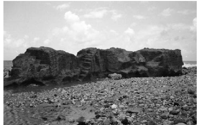
PHOTO 11 - SIDON : CREUSEMENTS EN ESCALIER SUR LA FACE INTERNE DU MUR DE MER (Cliché J. VIRET, 1998)
