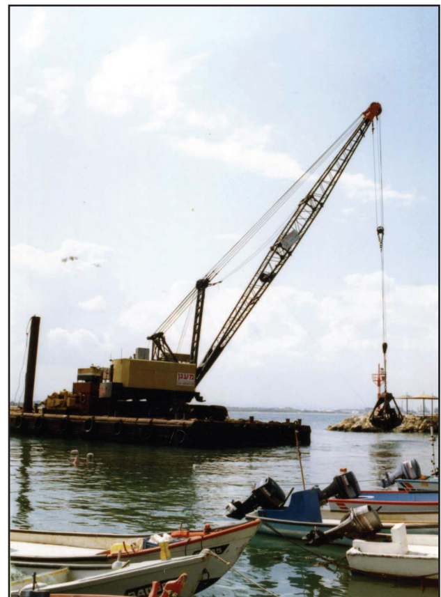
Fig. 5: The dredger that deepened the marina (J. Galili)
