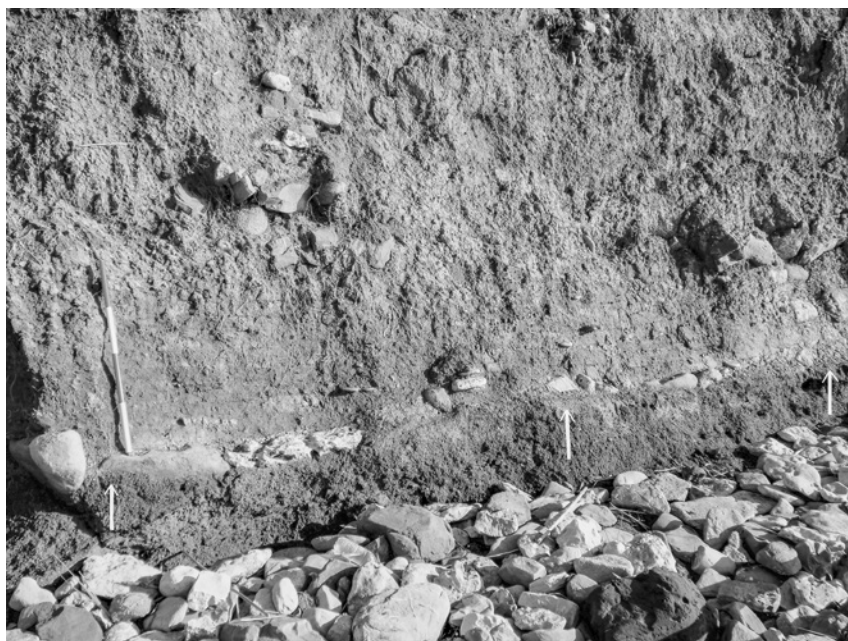
Fig. 10 - Spiaggia di Pyrgi: il muro in mattoni crudi di epoca arcaica affiorante alla base della sezione esposta sulla spiaggia dall'erosione del mare. La muratura in mattoni crudi si appoggia su una base di pietre di fondazione. I mattoni risultano legati con uno strato di argilla di colore grigio che permette di distinguere bene la tessitura del muro. Si nota l'uso di ciottoli fluitati inseriti come spessori tra un elemento e l'altro.
