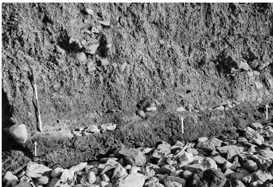
FIG. 8. Il piano di spiccato del muro in mattoni crudi di argilla basato su un solo strato di pietre di fondazione.
