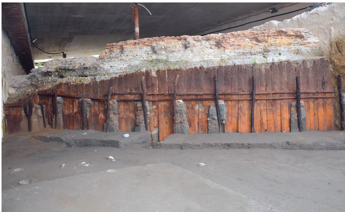
Fig. 10 – Molo con cassaforma lignea (I secolo d.C.) (Soprintendenza ABAP Napoli).
