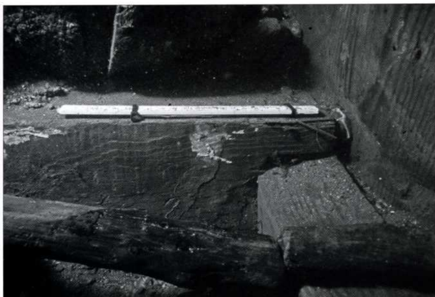
14. - Dettaglio del sistema di bloccaggio della traversa orizzontale esterna.
