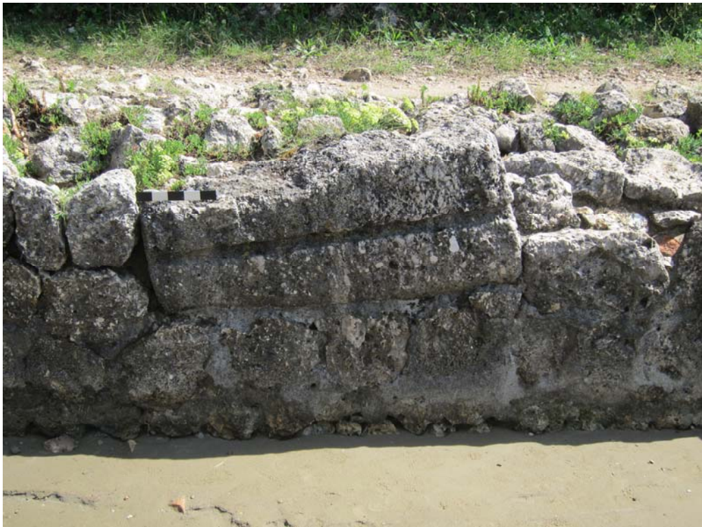
Fig. 8 - Blocco scanalato reimpiegato nelle strutture
