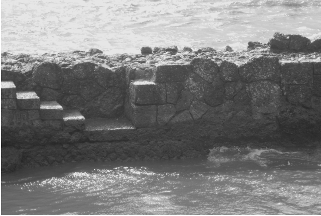
Fig. 15 - Strutture antiche e moderne
