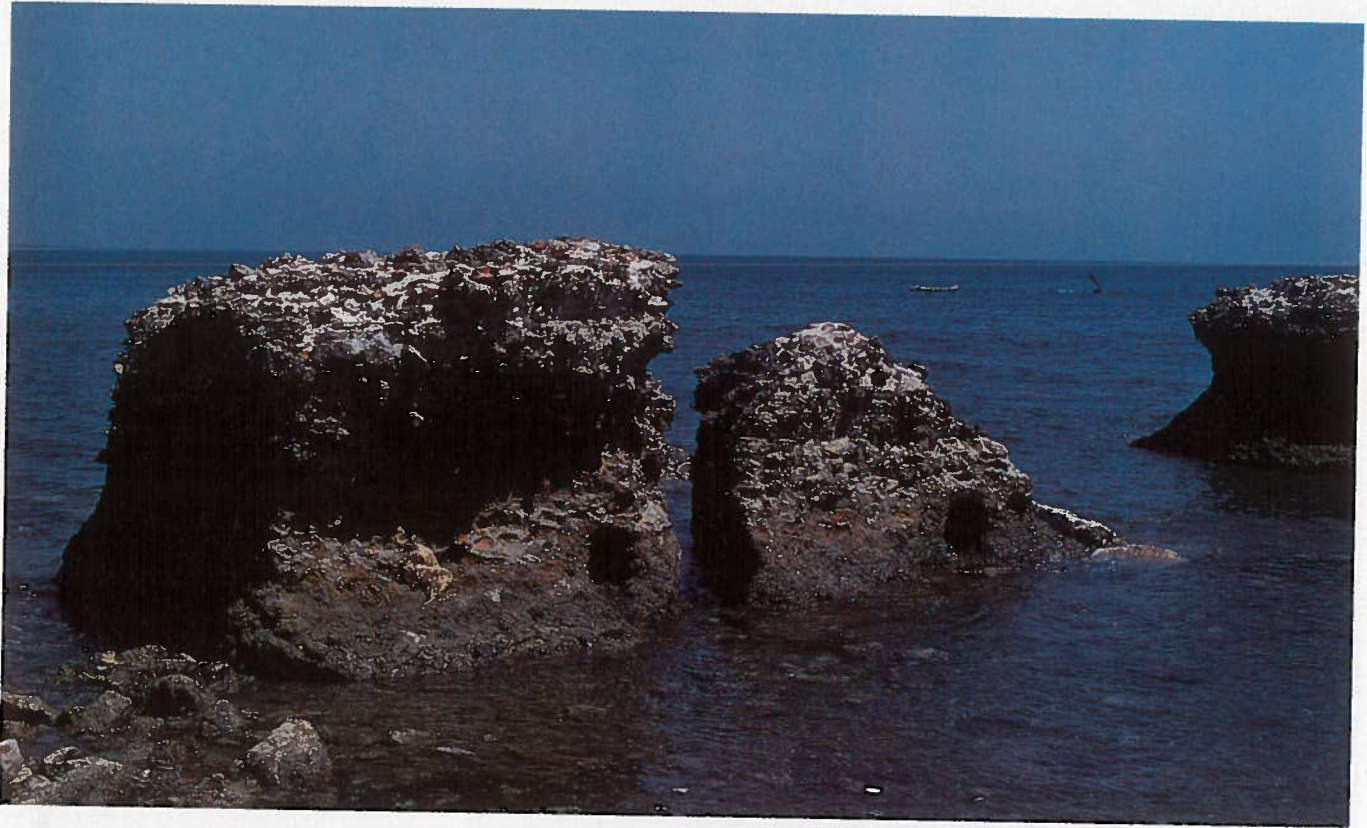
5. CE PILIER DE BÉTON résiste à la mer depuis quelque 2000 ans, dans le port de Cosa. Le mortier utilisé est un mélange de pouzzolane (une cendre volcanique), et de chaux, qui résiste à l'eau douce ou salée. Dans la couche supérieure (la plus claire), la
