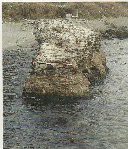
Fig. 7 – Il pilone 2, da sud. Sul lato est le impronte dei legnami da costruzione.
