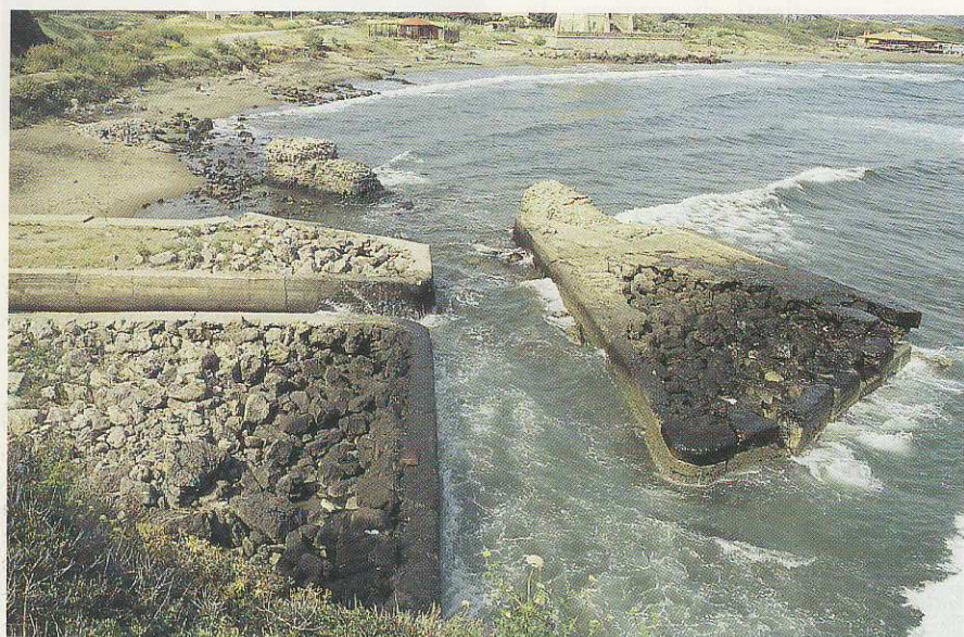
Fig. 4 - Idem, da sud. Si nota il pilone 3 ammorsato in un'opera moderna in cemento.
