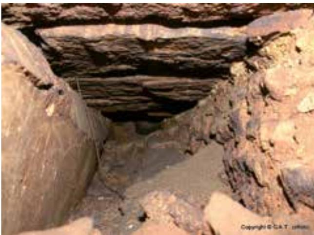
Fig. 5 L'interno dello speco del condotto: s'intravedono le pareti laterali in malta idraulica in parte crollate e la copertura a lastre di pietra.
