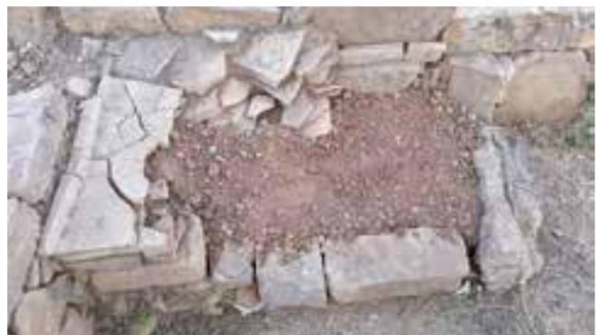
Fig. 18 Realizzazione di un muro a secco di contenimento
