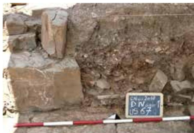
Fig. 11 Parete ovest, ammorsatura del tramezzo sulla risega interna delle mura del *castrum*.
