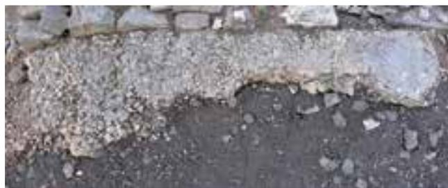
Fig. 9 Il pavimento in cocciopesto dopo la pulitura
