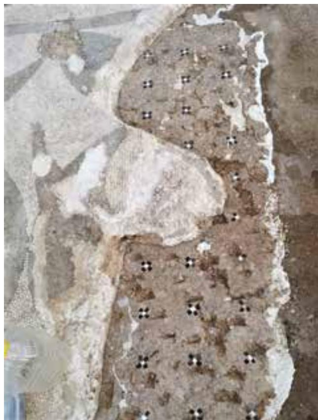
Fig. 9 Pavimento inferiore in cementizio, dettaglio della zona sud durante il restauro. Evidenti le intaccature praticate per offrire maggior appiglio al massetto preparatorio del pavimento in tessellato soprastante
