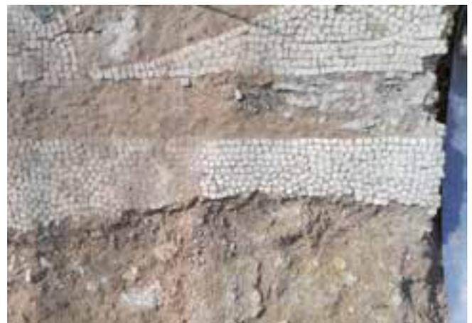
Fig. 3 Particolare del differente degrado tra tessere bianche e tessere nere
