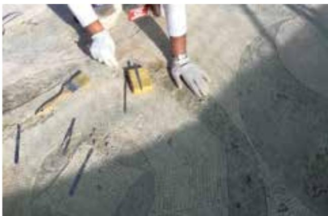
*Fig. 5 Rimozione dei depositi superficiali*
