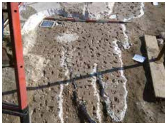
*Fig. 10 Realizzazione del cordolo di contenimento del pavimento*
