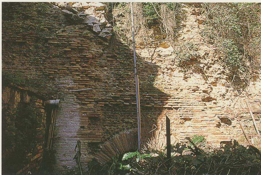
Fig. 1 – Anzio, resti di muraure in opera mista inglobati nelle sostruzioni di Villa Sarsina.
