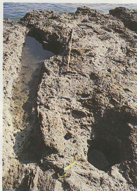
Fig. 9 - Anzio, porto neroniano: molo est, blocco II, palo montante al piede d'opera.
