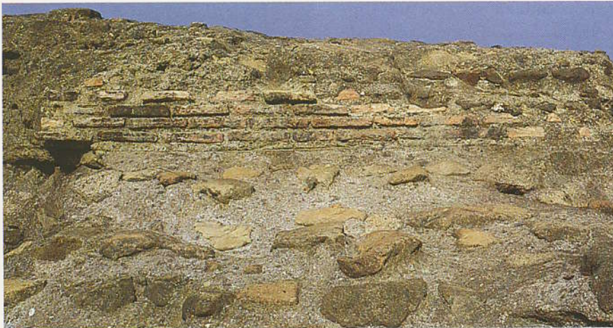
Fig. 5 - Anzio, porto neroniano: molo ovest, blocco I, resti del paramento in laterizio dell'elevato.
