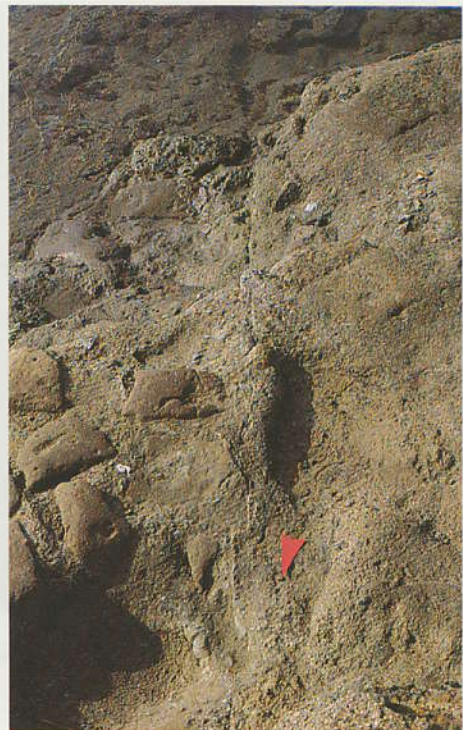
Fig. 21 - Anzio, porto neroniano: molo ovest, blocco I/platea, giunzione di gettate con impronta del tavolato di contenimento.
